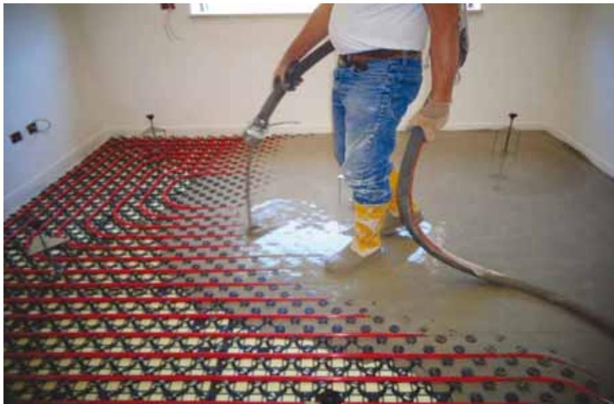
Esempi di impianti a pavimento radiante
