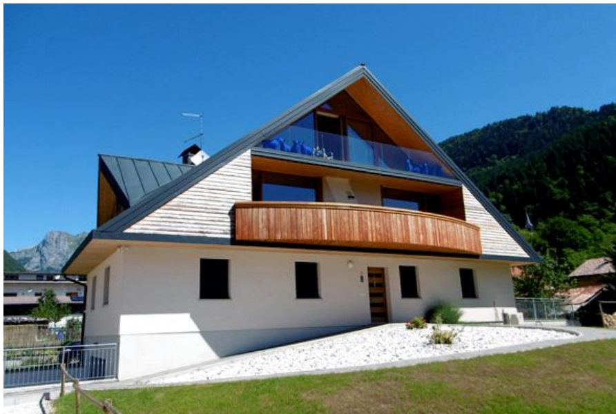
Viste esterne preesistente e post intervento
