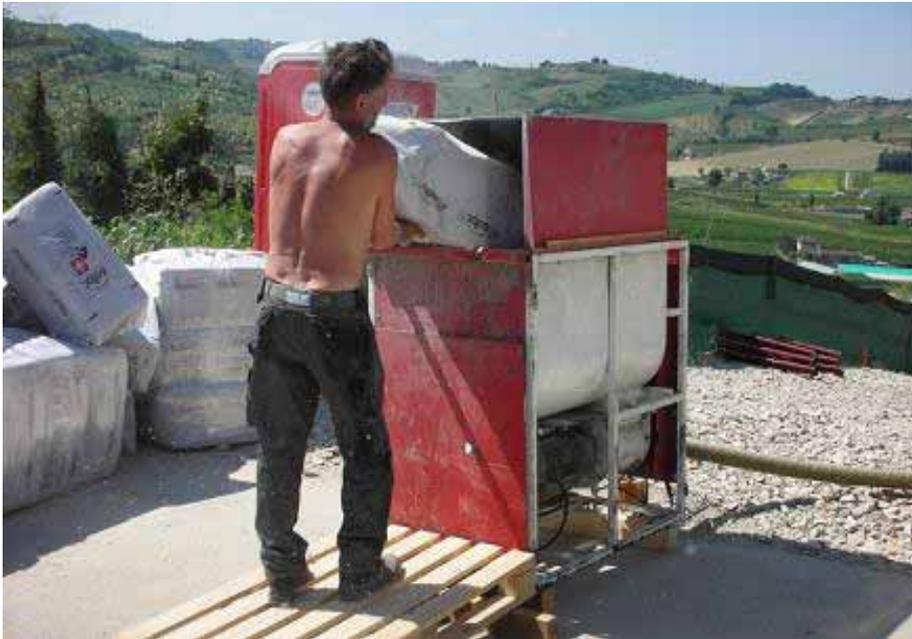
Coibentazione con insufflaggio di cellulosa
