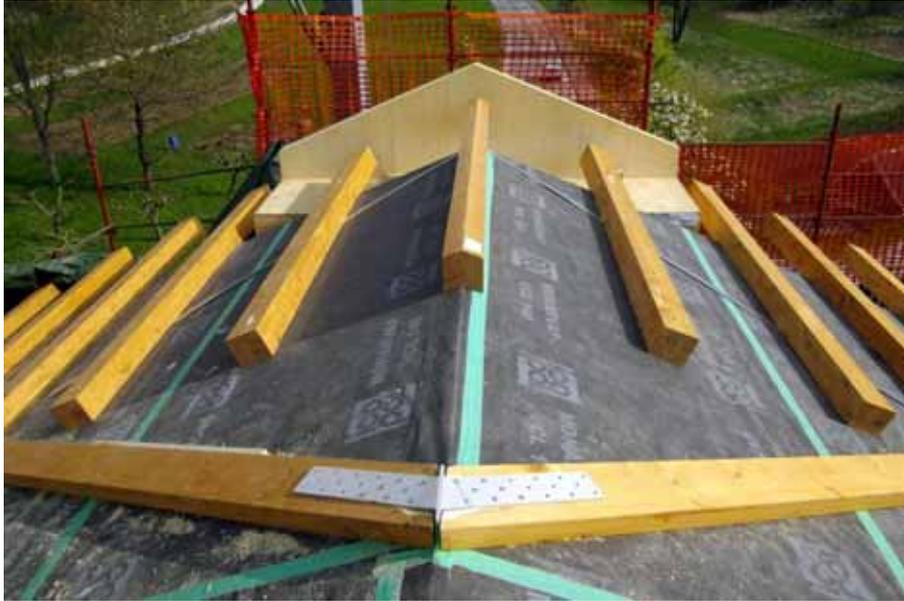
Sistema strutturale sbalzo di copertura
