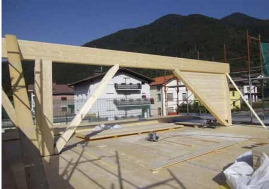
Telaio su primo solaio X-lam 200 mm
