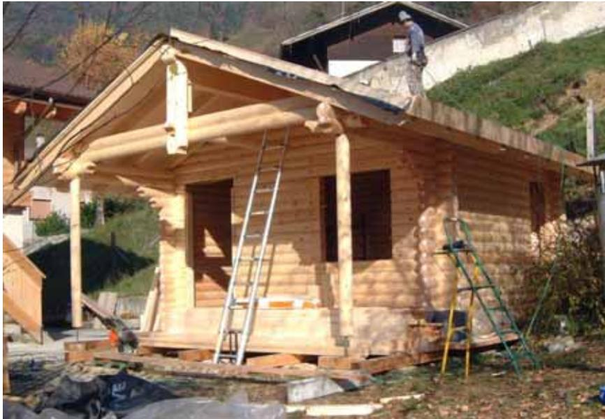
Struttura tipo Blockbau
