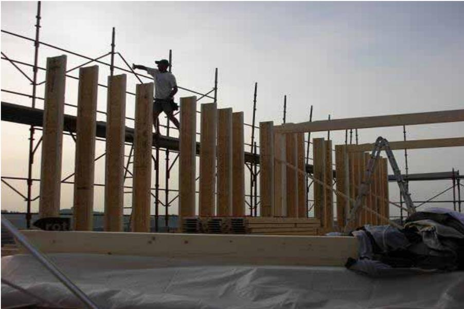
Fase di assemblamento profilati FIJ portanti
