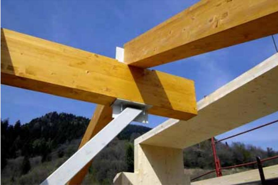
Sistema strutturale sbalzo di copertura
