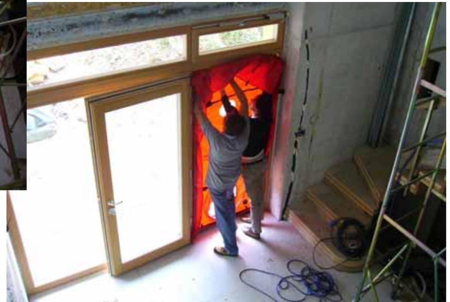
Analisi e test di tenuta all'aria – Ruggero Panigutti – SCANTEC S.r.l. – Tavagnacco (Udine)
