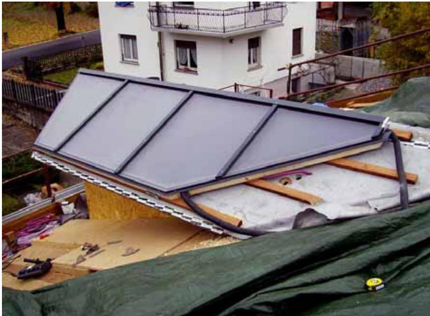
Collettore solare realizzato su misura
