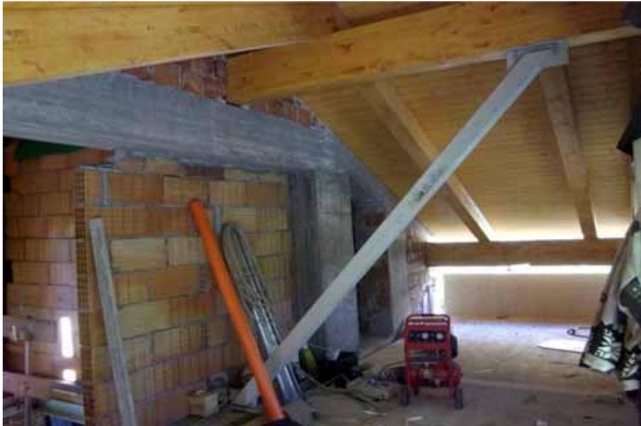
Sistema strutturale sbalzo di copertura
