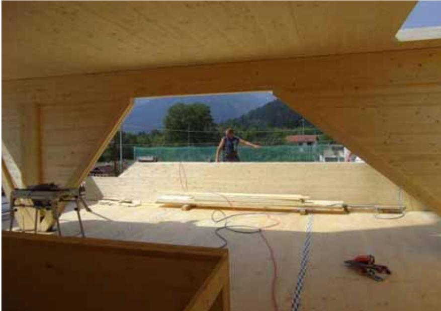
Telaio reggi secondo solaio X-lam 140 mm
