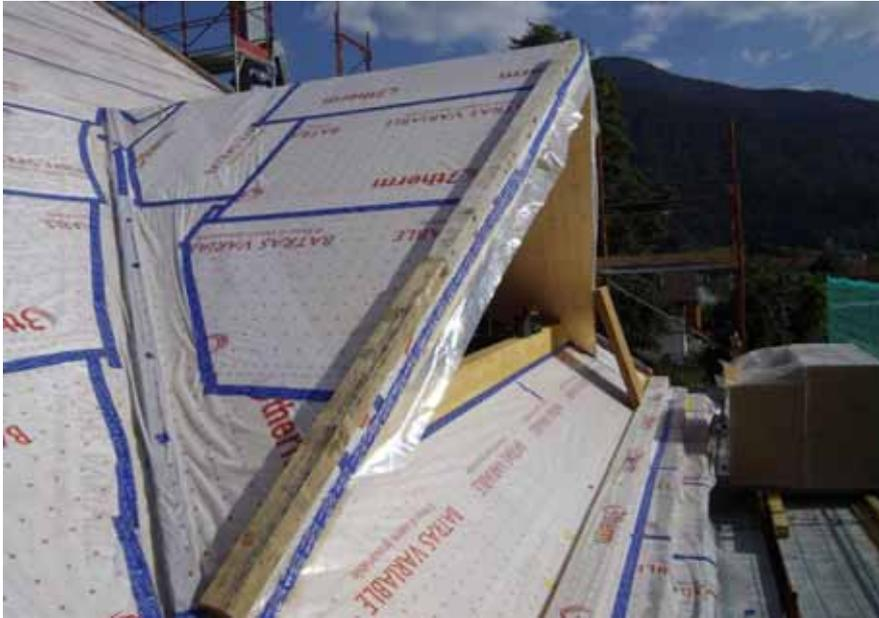
Freno vapore ed isolamento 180 mm
