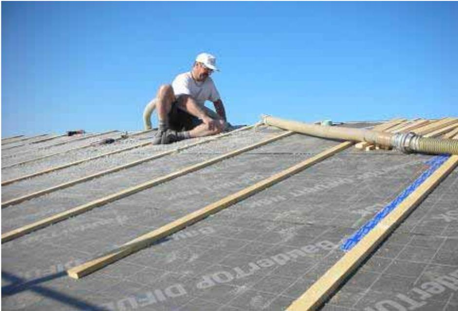
Coibentazione con insufflaggio di cellulosa
