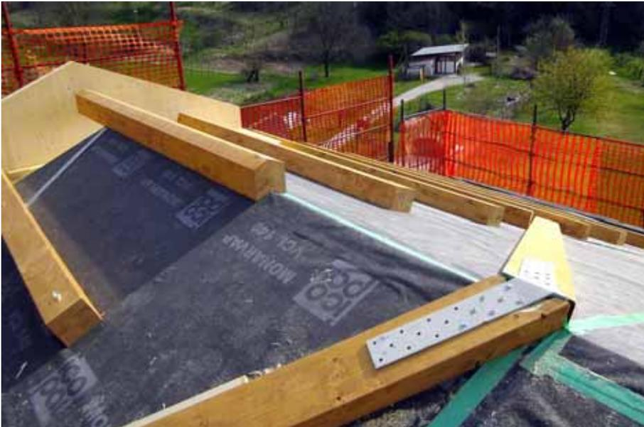
Sistema strutturale sbalzo di copertura
