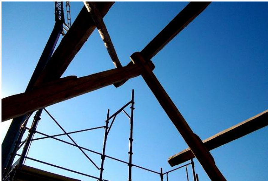
Mantenimento strutture copertura lignea
