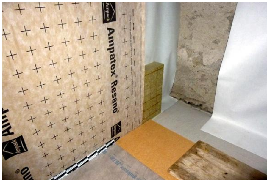
2/3 Isolamento continuo contro murature
