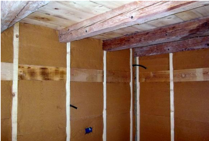
1/3 Isolamento intercapedine impiantistica
