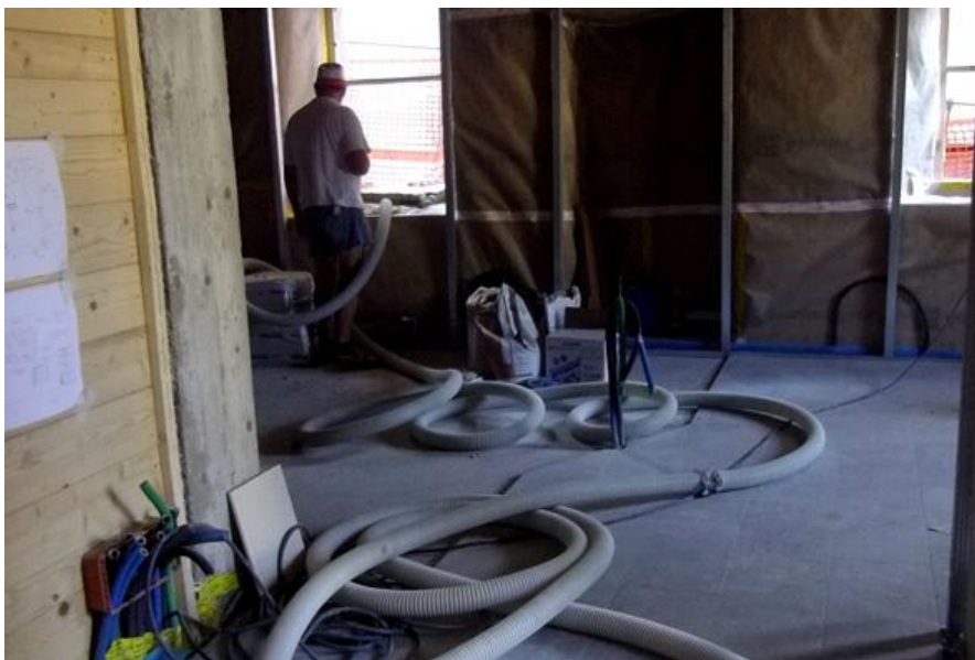
Isolamento insufflato entro casseri in legno
