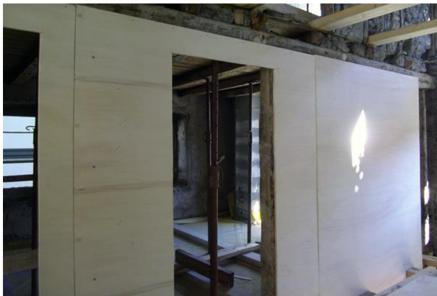
Pannelli di compensato irrigidenti muri intelaiati
