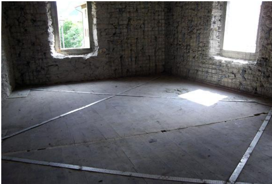
Nastri metallici di controventamento in piano
