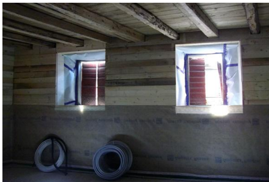
Contropareti perimetrali a cassero in legno
