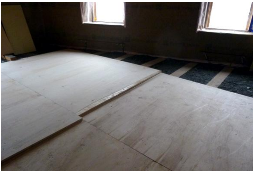
Travi collaboranti legno-legno di rinforzo solai
