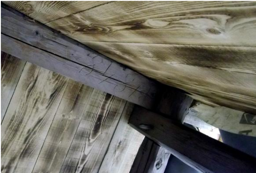
Recupero in sito trave di colmo del 1848
