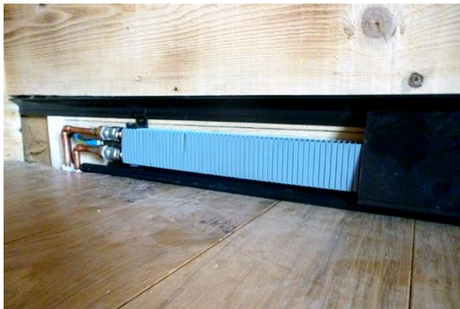
Battiscopa radiante ad acqua ed elettricità
