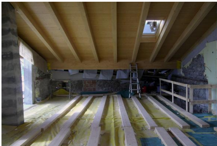
Travi collaboranti legno-legno di rinforzo solai
