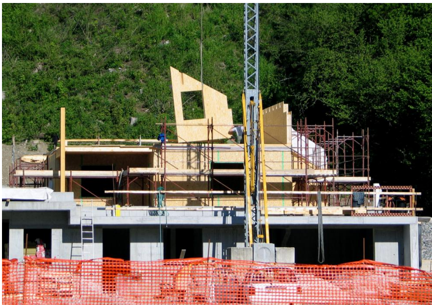
Sistemi intelaiati e controventati con pannelli
