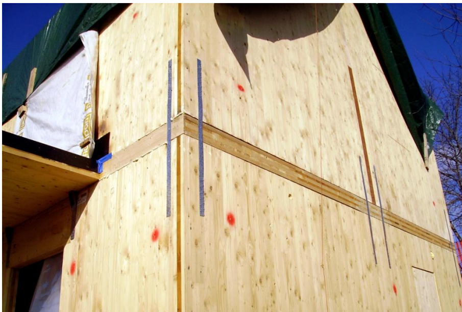
Esempi di ancoraggi tipo per struttura X-lam
