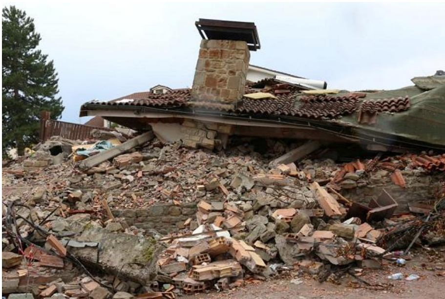
Collassi totale con schiacciamento dall'alto
