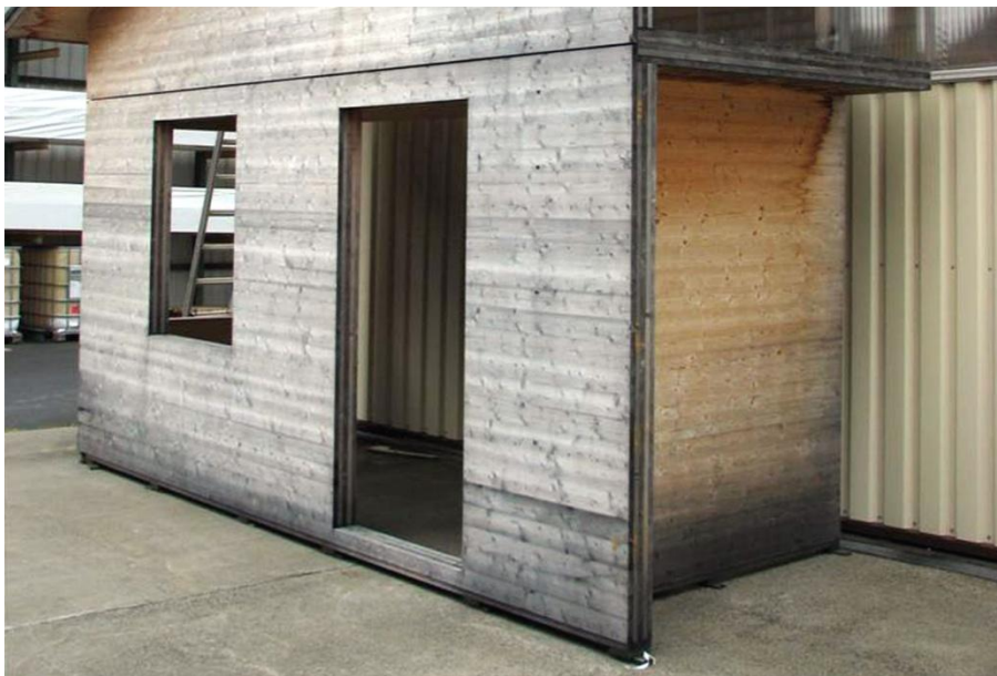
Resistenza alle intemperie Sistema CLT
