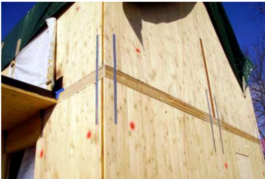
Esempi di ancoraggi tipo per struttura X-lam
