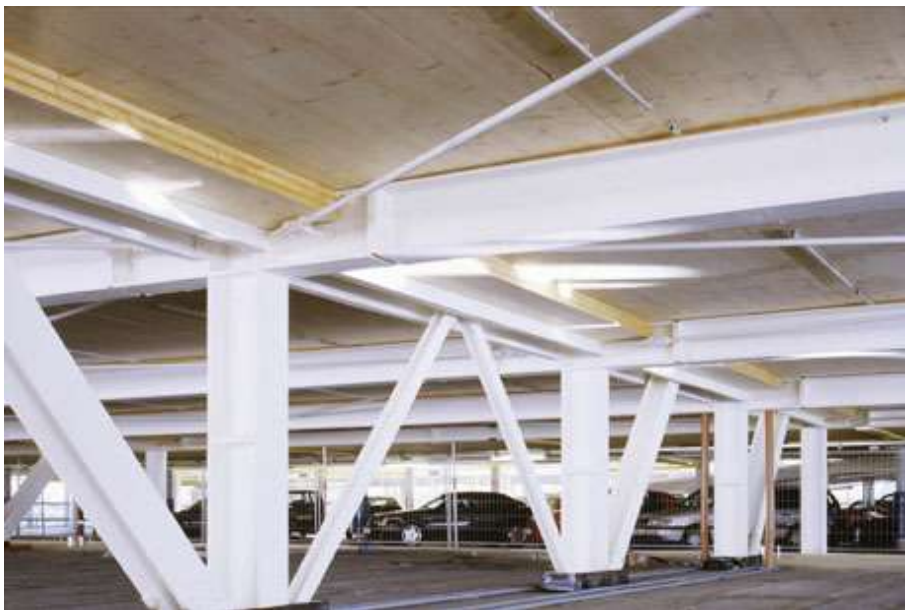
Resistenza strutturale al fuoco Sistema CLT
