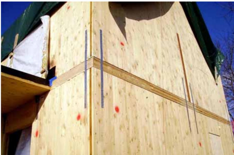
Esempi di ancoraggi tipo per struttura X-lam
