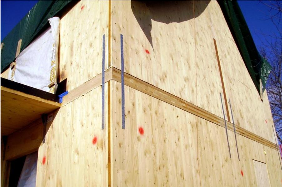
Esempi di ancoraggi tipo per struttura X-lam
