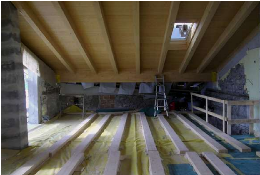
Travi collaboranti legno-legno di rinforzo solai
