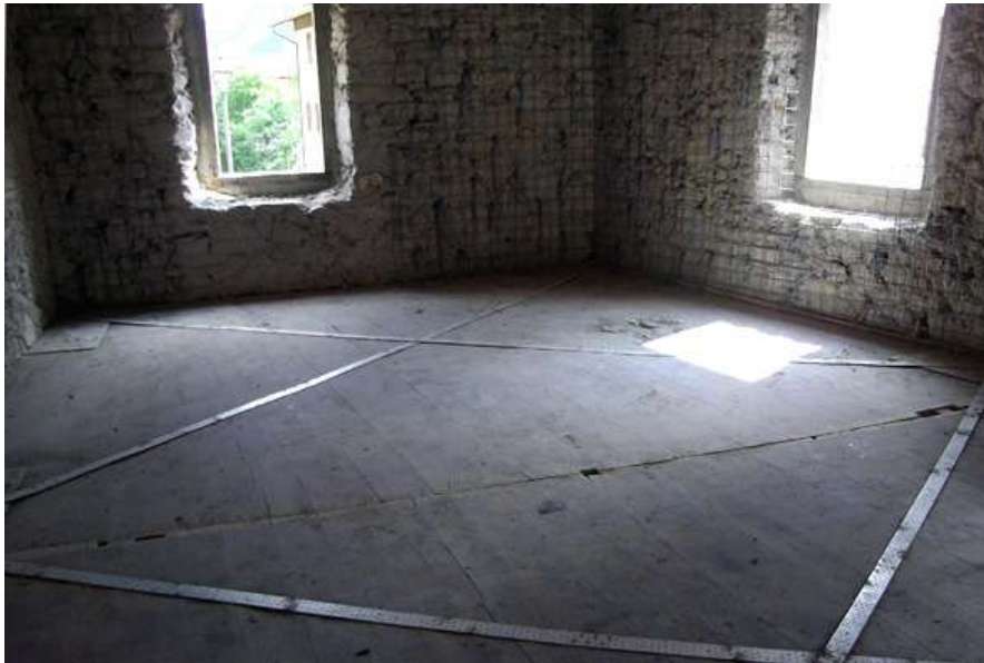
Nastri metallici di controventamento in piano
