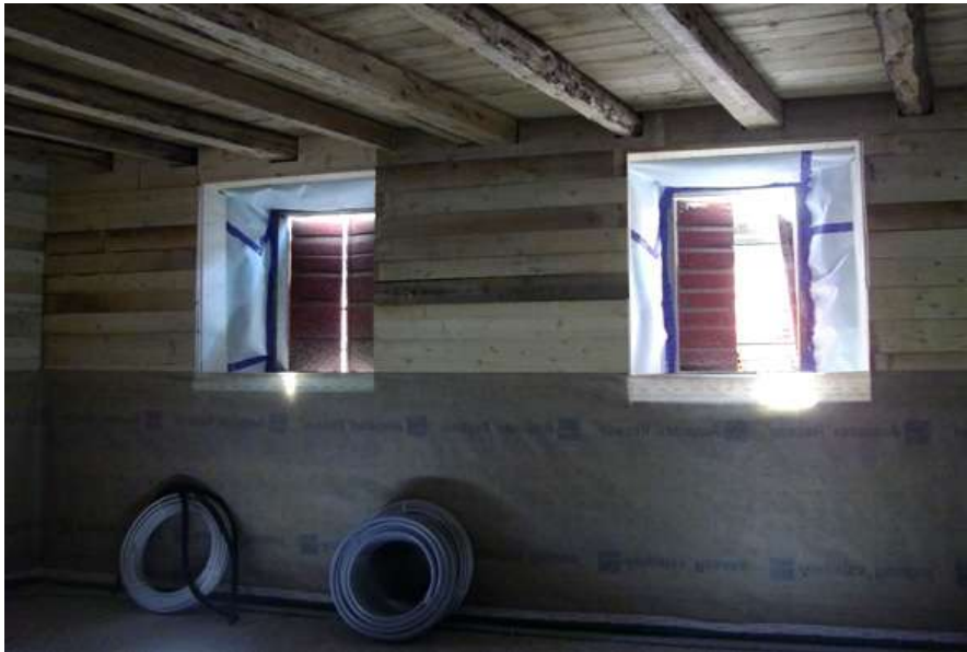
Contropareti perimetrali a cassero in legno
