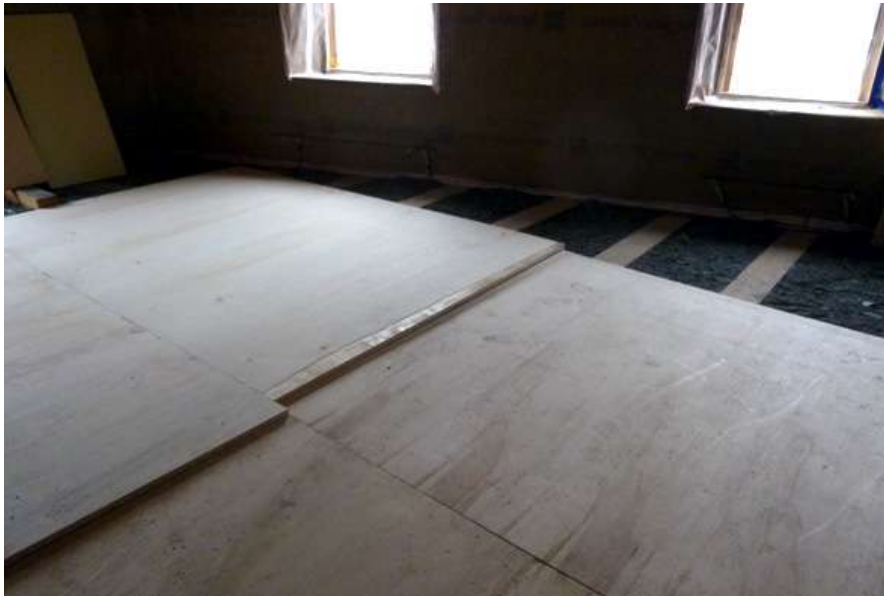
Travi collaboranti legno-legno di rinforzo solai
