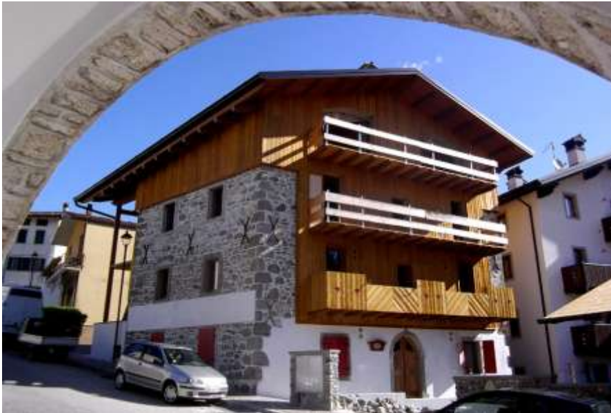
Viste esterne preesistente e post intervento
