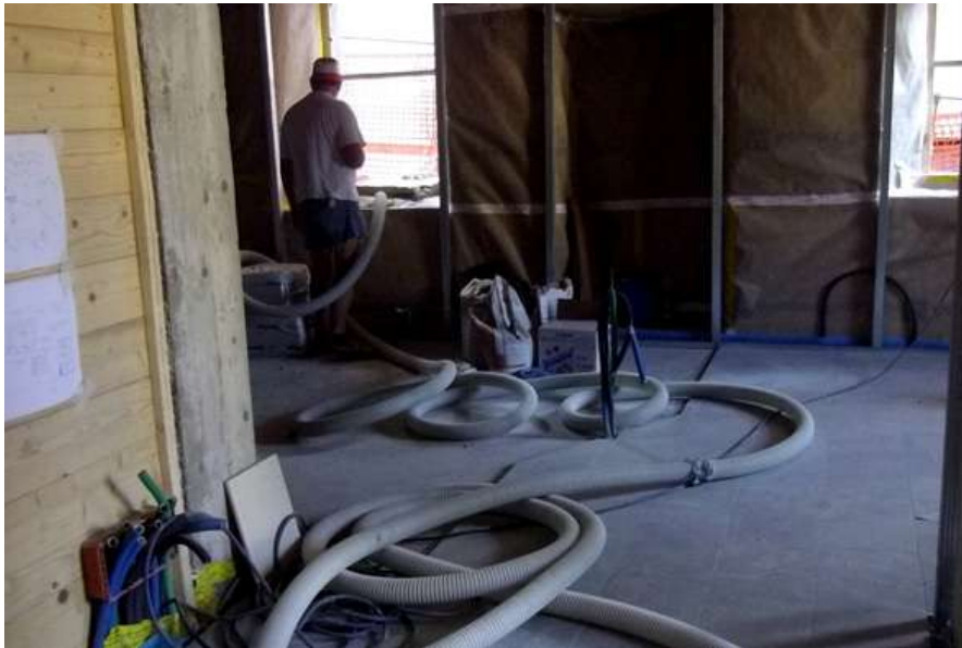
Isolamento insufflato entro casseri in legno
