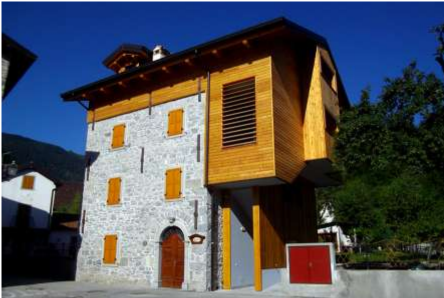
Viste esterne preesistente e post intervento
