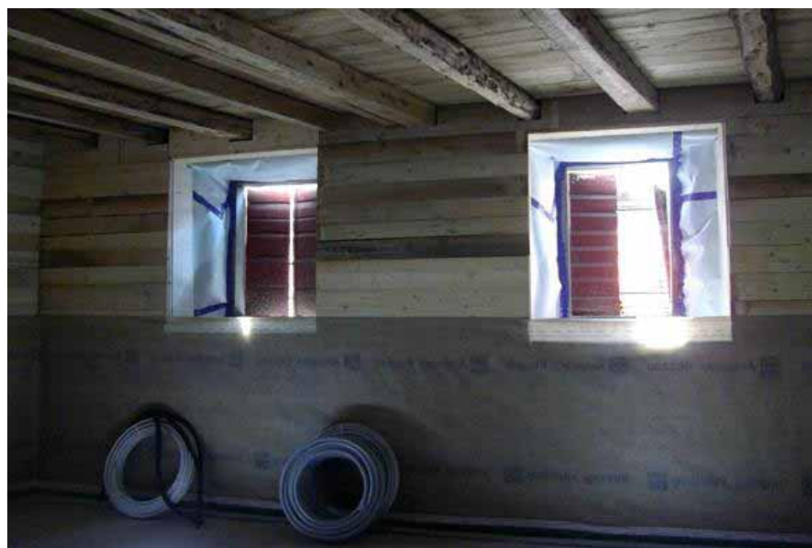
Contropareti perimetrali a cassero in legno
