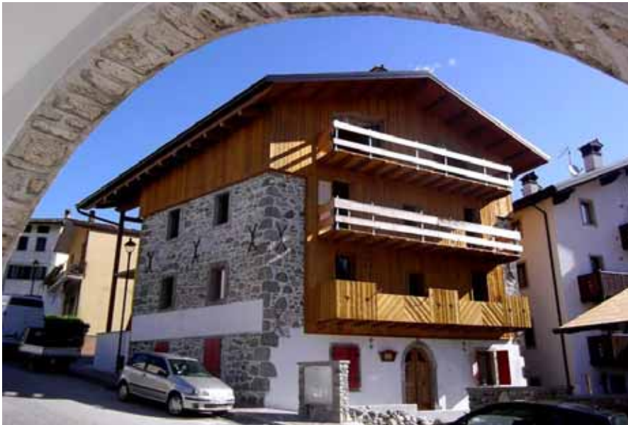
Viste esterne preesistente e post intervento
