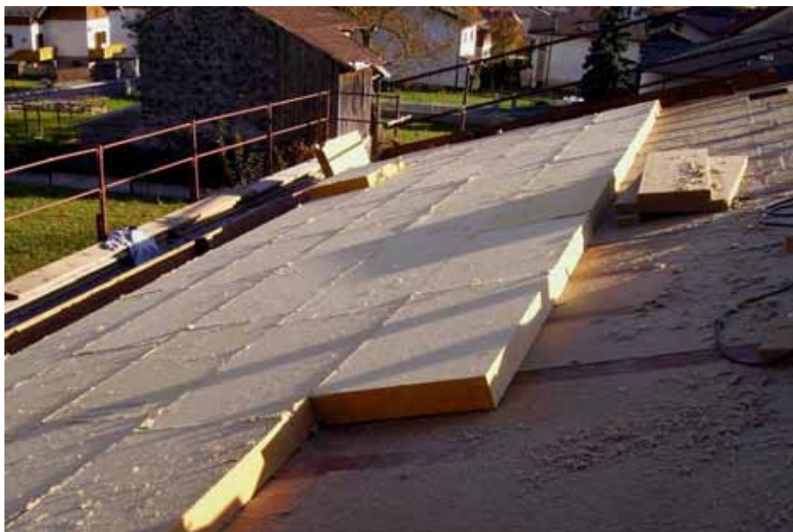
Travetti di rinforzo entro isolamento tetto
