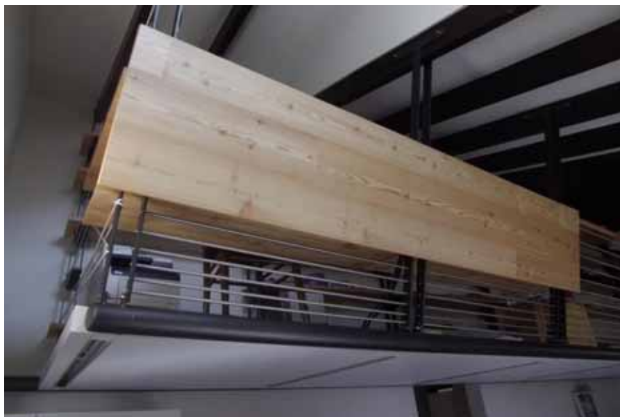
Soppalco interno appeso alle travi rinforzate
