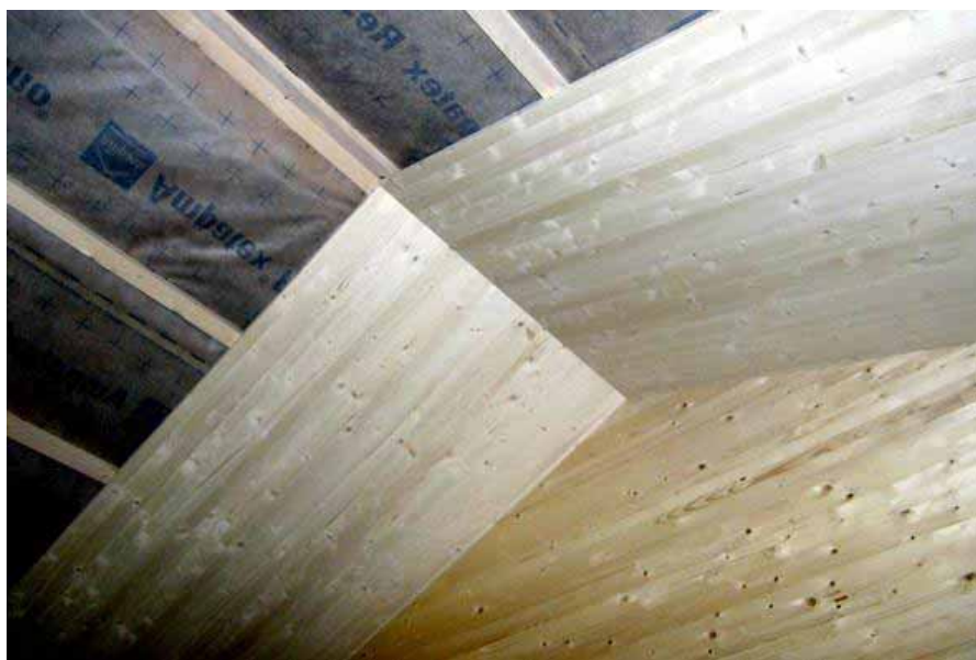
Volume X-lam, pannelli controsoffitto sotto telo
