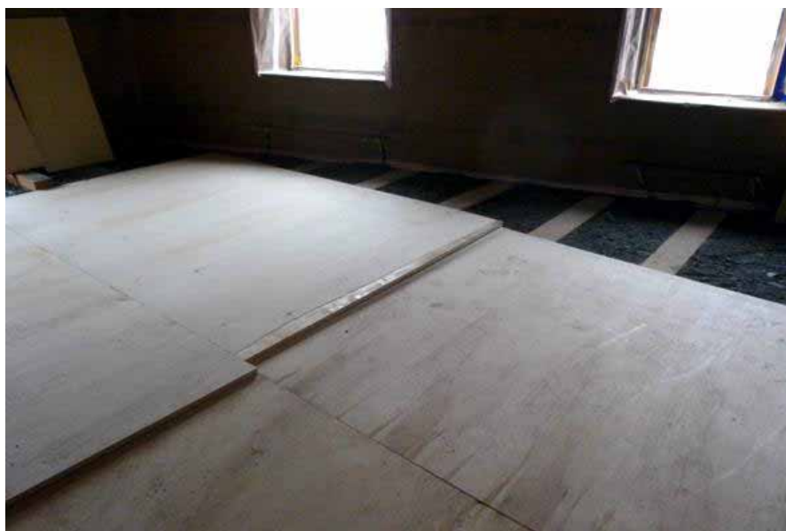
Travi collaboranti legno-legno di rinforzo solai
