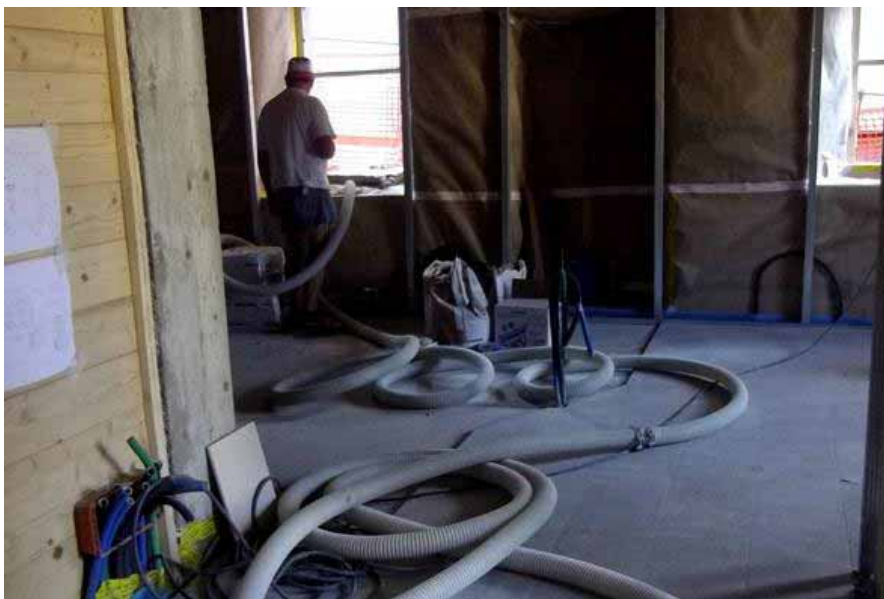
Isolamento insufflato entro casseri in legno
