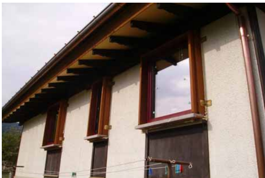
Alloggiamento finestre monoblocco a sbalzo
