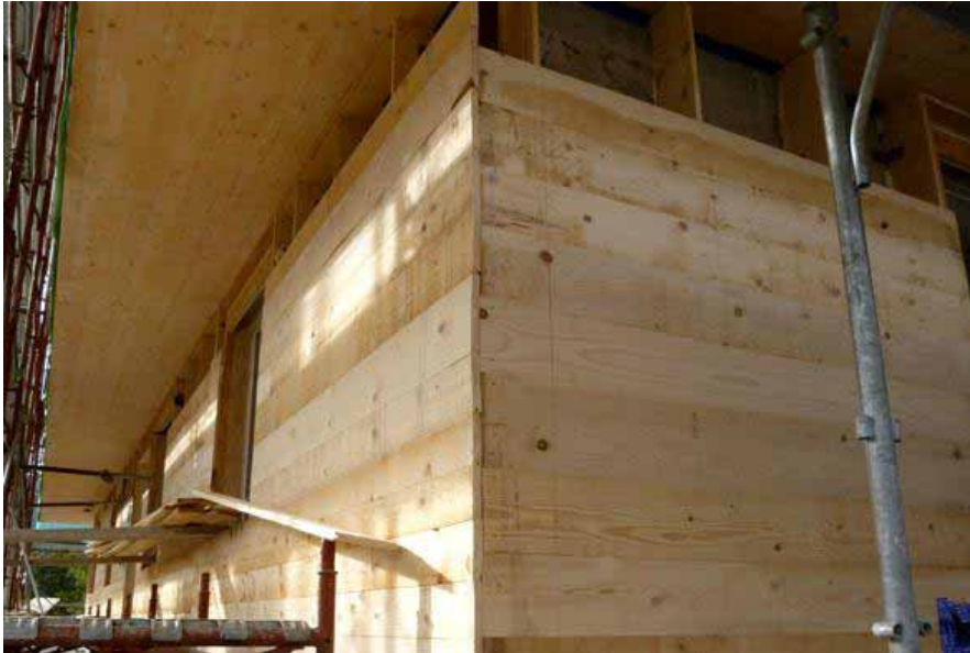
Realizzazione casseri lignei sulle murature
