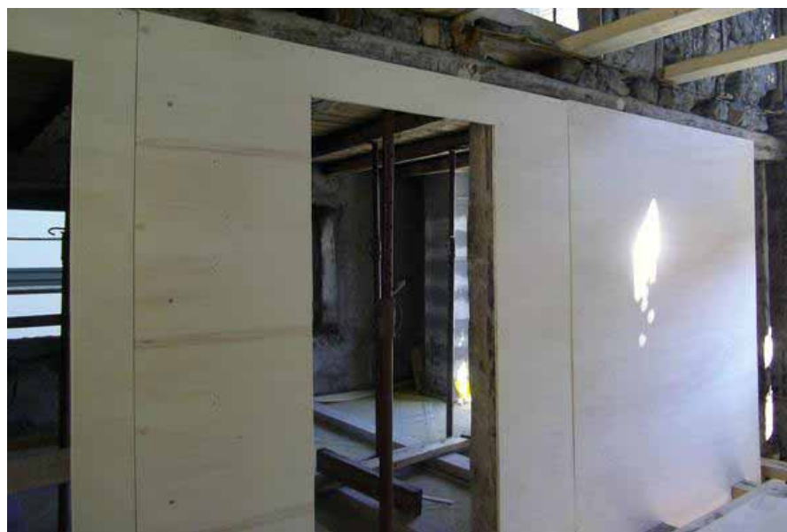
Pannelli di compensato irrigidenti muri intelaiati
