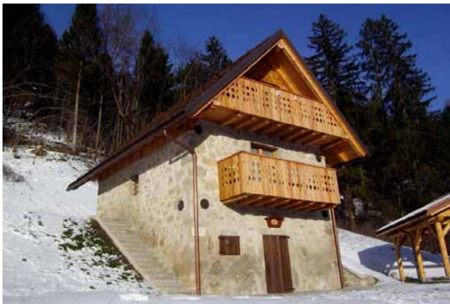
Viste esterne preesistente e post intervento
