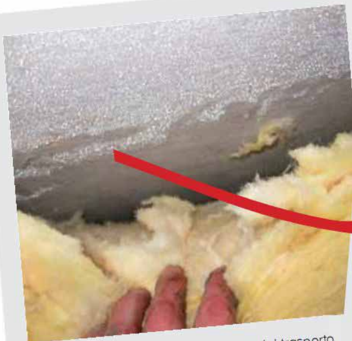
Membrana microporosa: la mancanza del trasporto attivo dell'umidità comporta strutture bagnate
