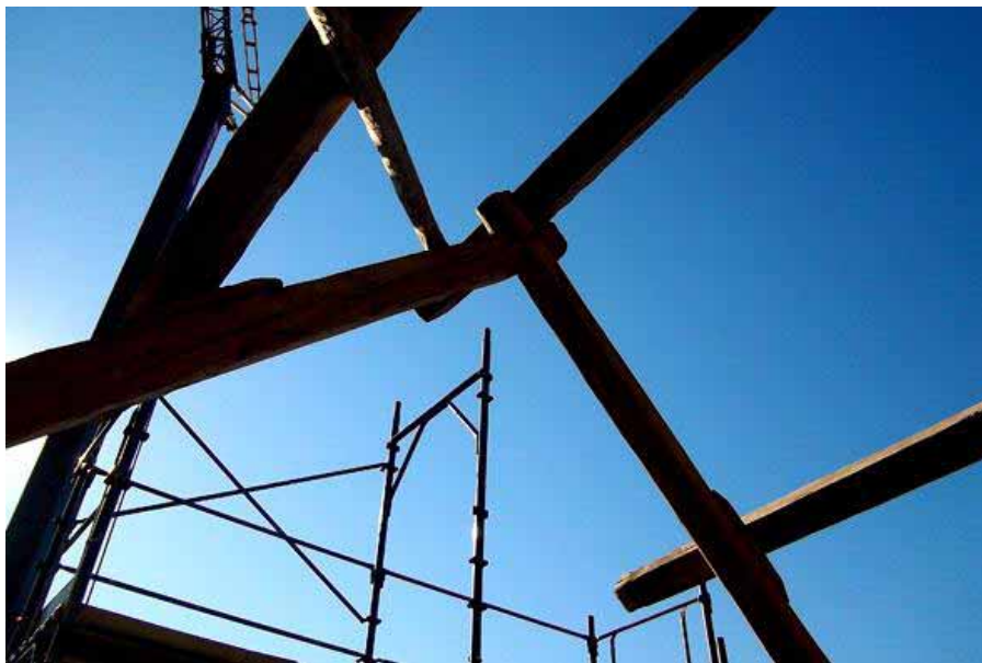
Mantenimento strutture copertura lignea
