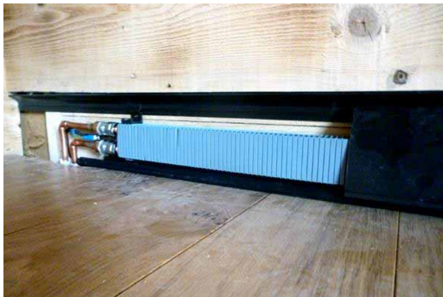
Battiscopa radiante ad acqua ed elettricità
