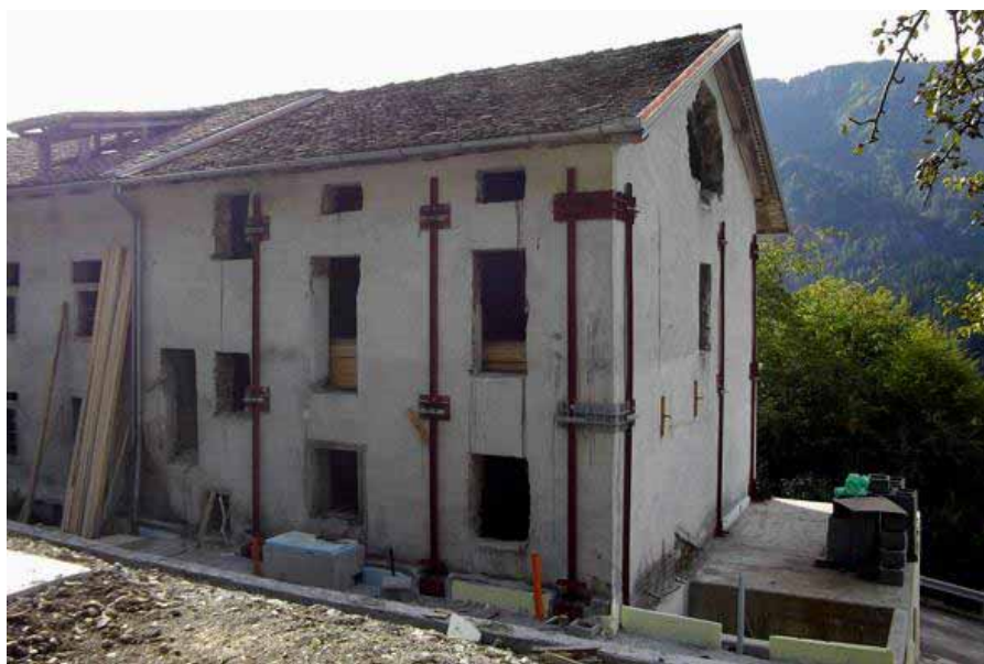
Rafforzamento murature con piastre e putrelle
