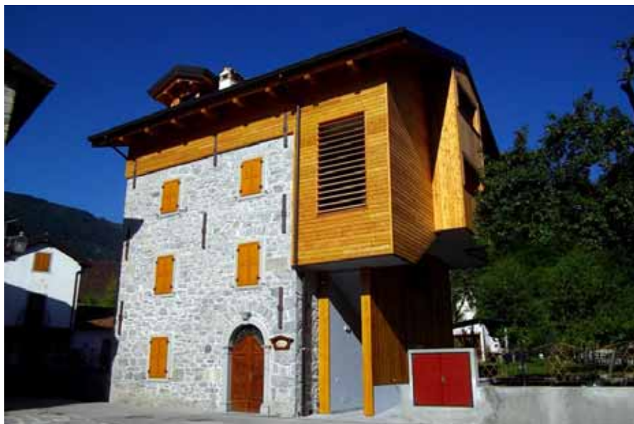
Viste esterne preesistente e post intervento
