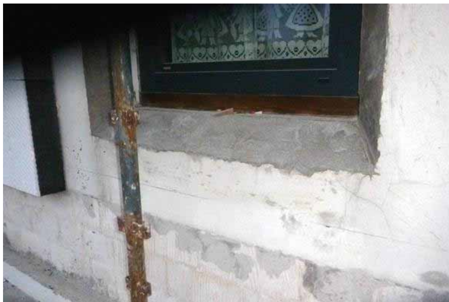
Taglio inclinato spallette per risvolto cappotto
