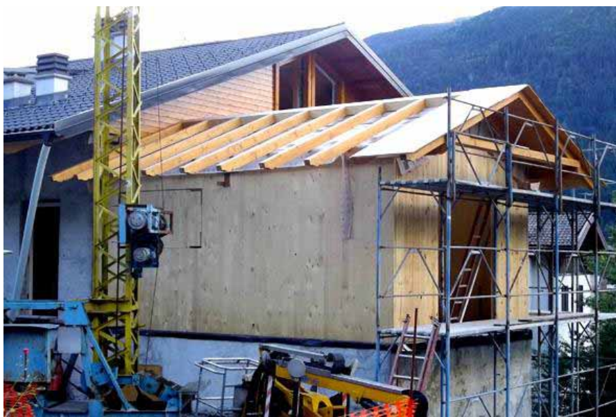
Volume X-lam, isolamento tra travi reggi telo
