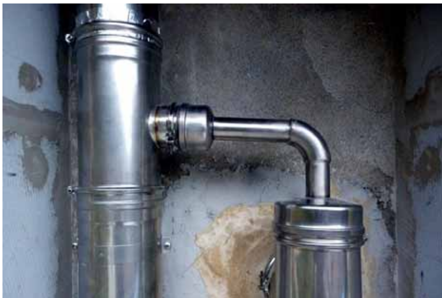
Girofumi con serpentine scambiatore ACS
