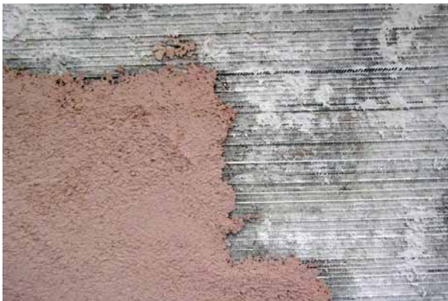
Intonaco alleggerito in perlite su rete zincata
