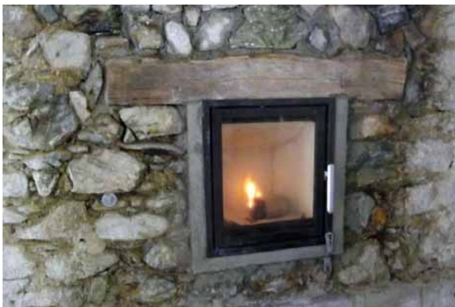
Inserto ad accumulo entro muro in pietrame
