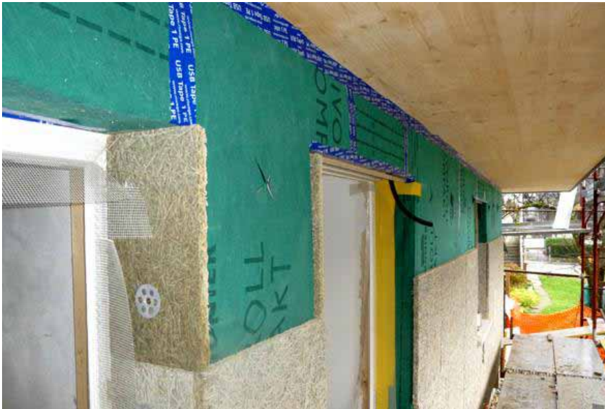
Applicazione pannelli porta intonaco su telo
