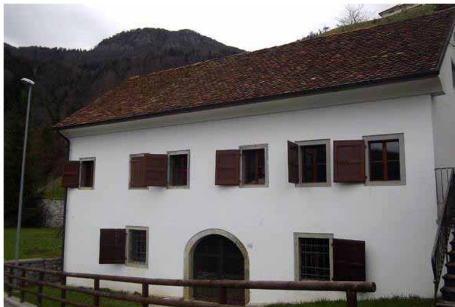
Viste esterne preesistente e post intervento
