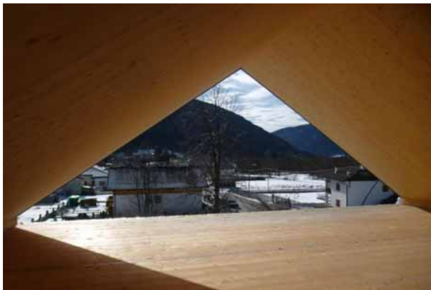
Copertura X-lam a vista con isolamento esterno
