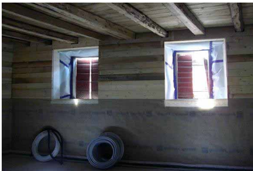
Contropareti perimetrali a cassero in legno
