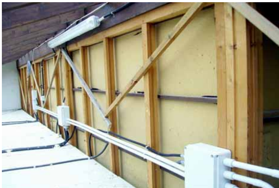
Sistema intelaiato da 75 mm di spessore
