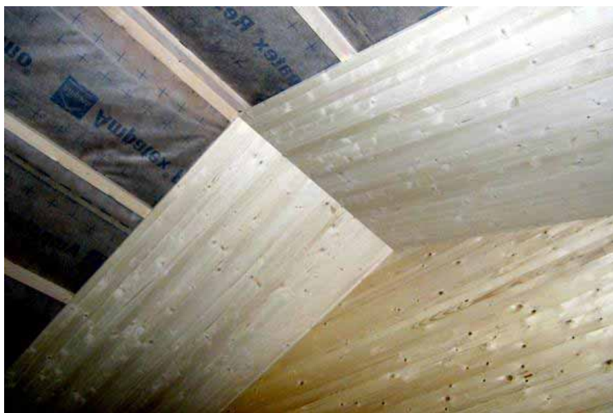
Volume X-lam, pannelli controsoffitto sotto telo
