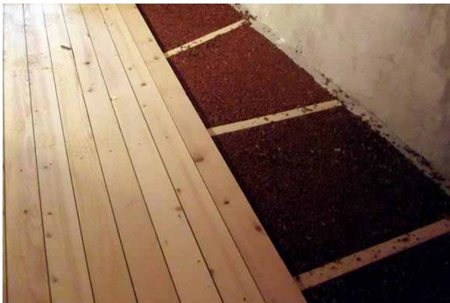
Sottofondi a secco in sughero granulare
