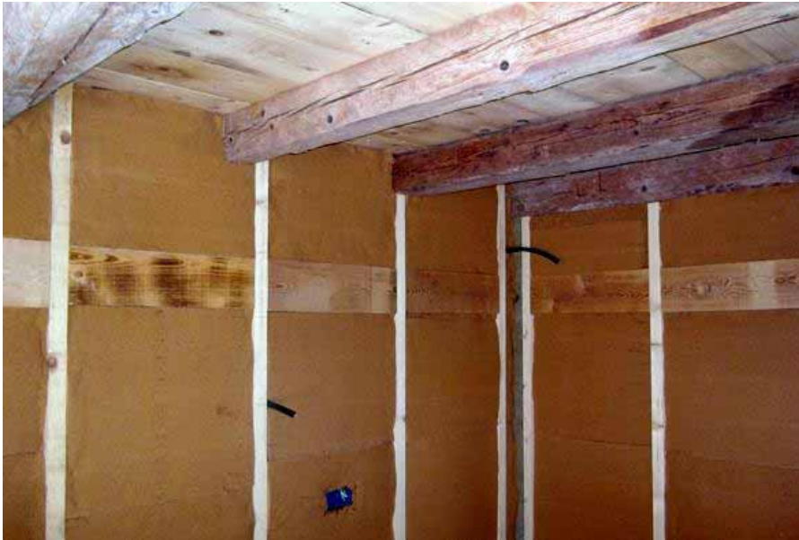
1/3 Isolamento intercapedine impiantistica
