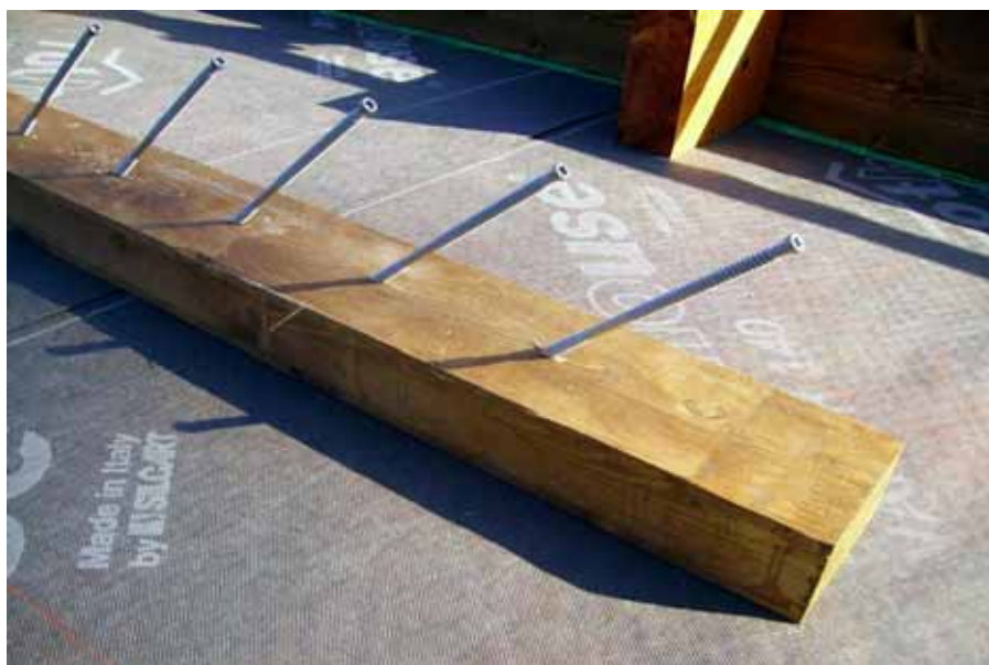
Rinforzo legno-legno travi di copertura
