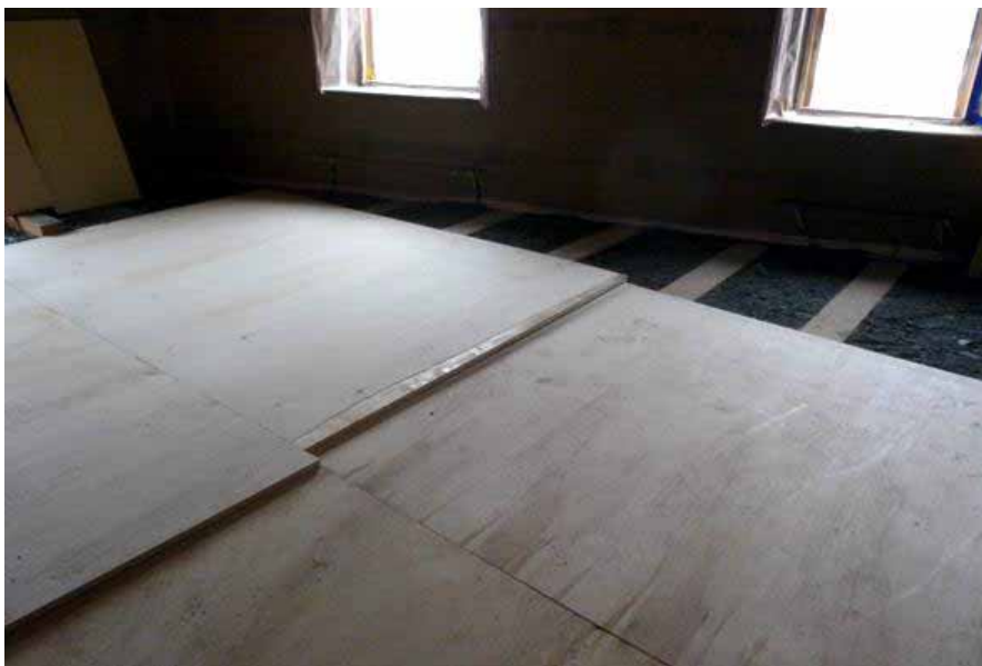
Travi collaboranti legno-legno di rinforzo solai
