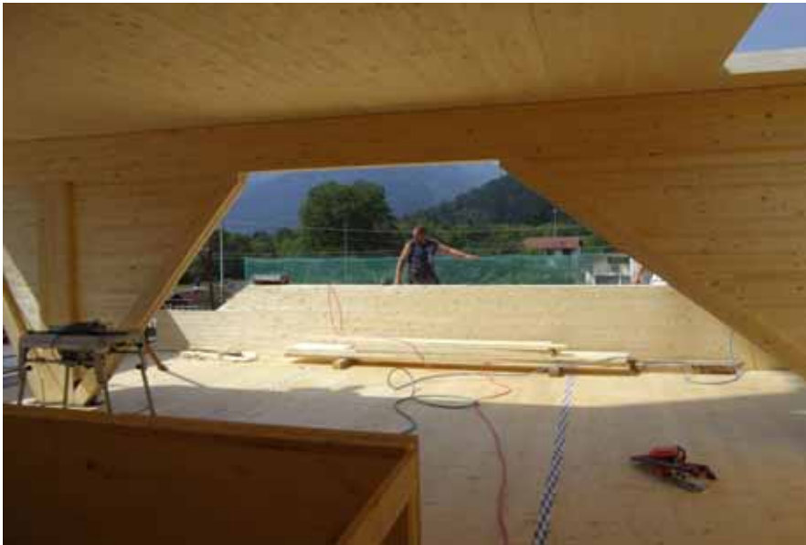
Coppia telai in L.L. reggi solaio mansarda
