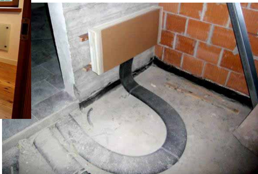
Distributori VMC con riscaldatori integrati
