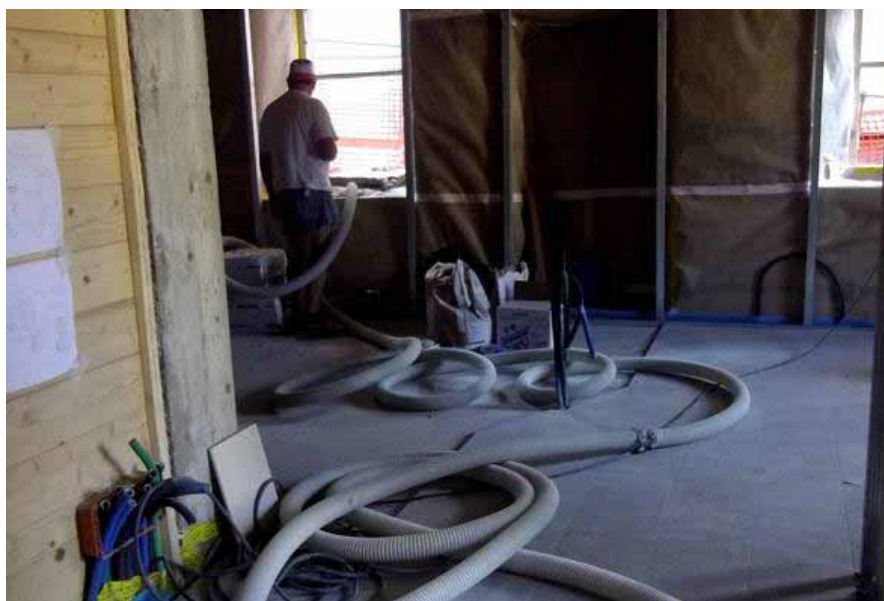
Isolamento insufflato entro casseri in legno
