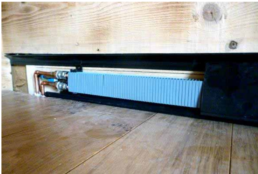
Battiscopa radiante ad acqua ed elettricità
