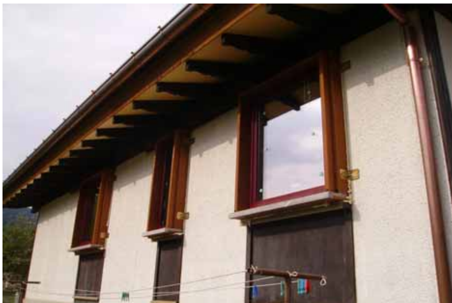
Alloggiamento finestre monoblocco a sbalzo
