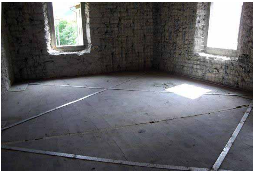
Nastri metallici di controventamento in piano
