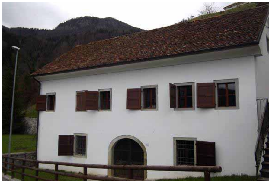
Viste esterne preesistente e post intervento
