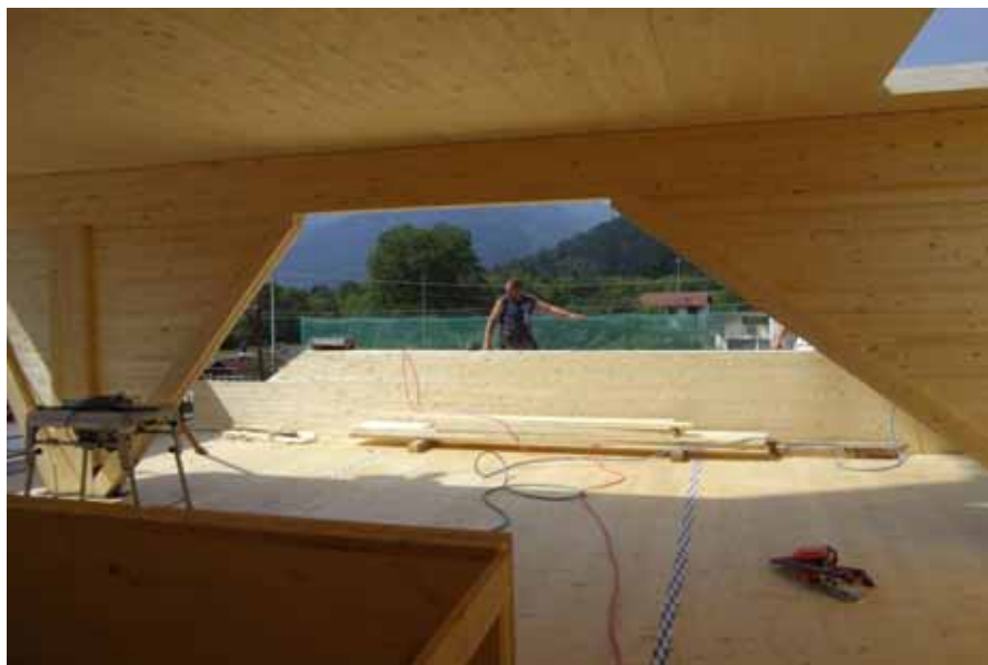
Coppia telai in L.L. reggi solaio mansarda
