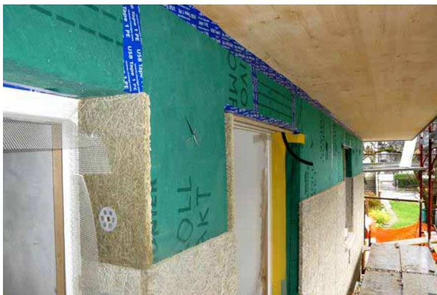
Applicazione pannelli porta intonaco su telo
