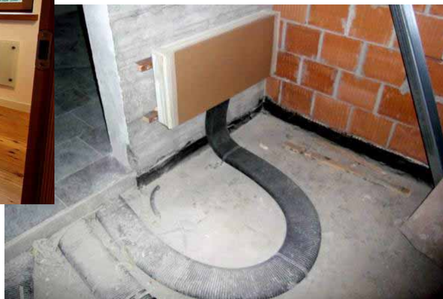
Distributori VMC con riscaldatori integrati
