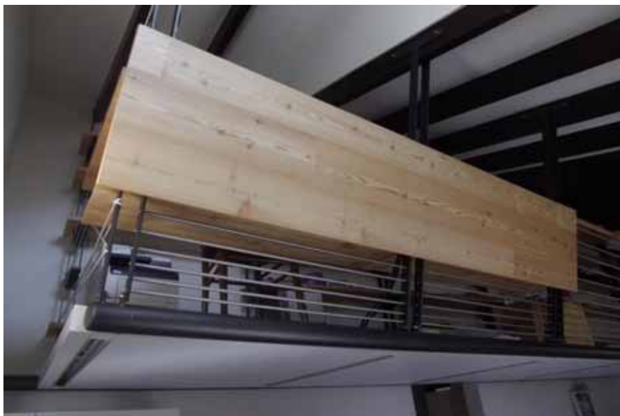
Soppalco interno appeso alle travi rinforzate
