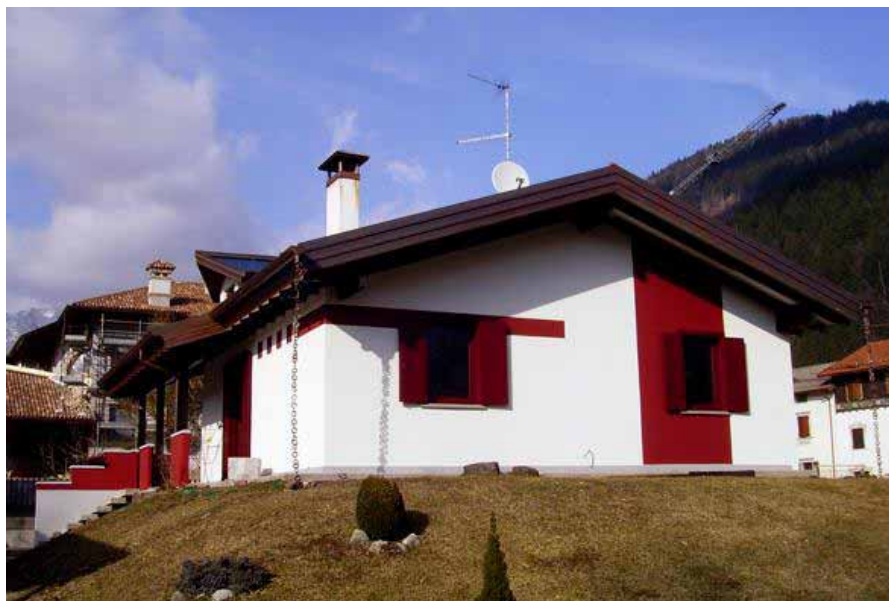
Viste esterne preesistente e post intervento
