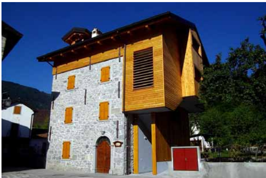
Viste esterne preesistente e post intervento
