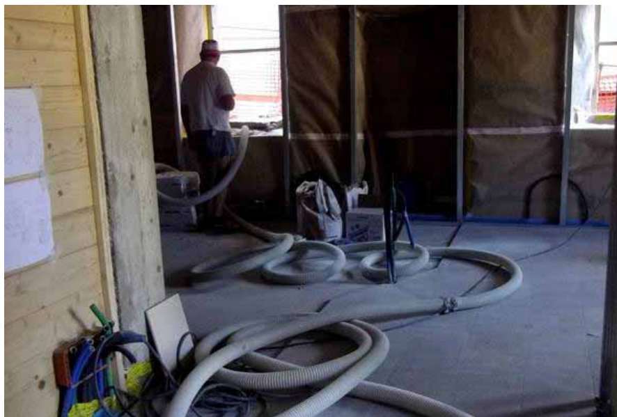
Isolamento insufflato entro casseri in legno
