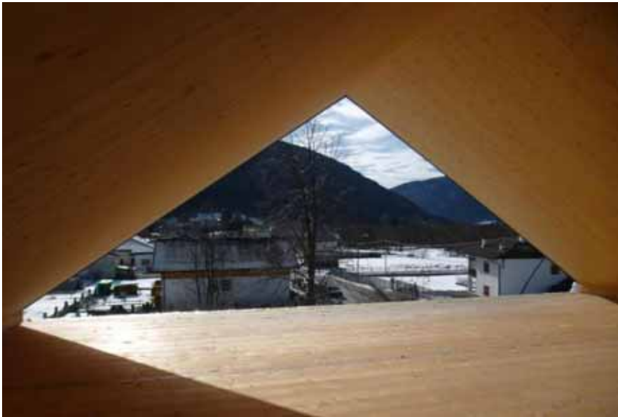
Copertura X-lam a vista con isolamento esterno
