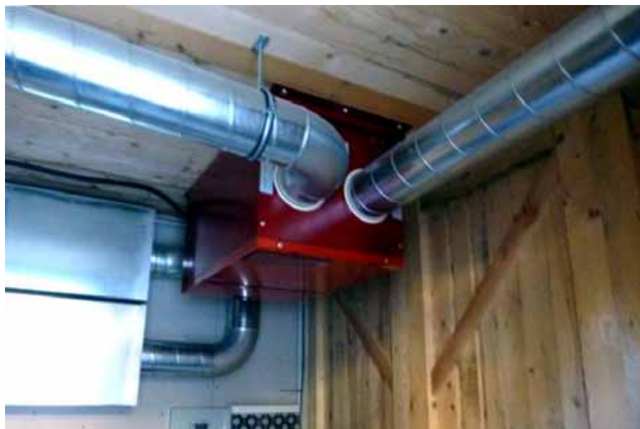
VMC entalpica senza batteria antigelo
