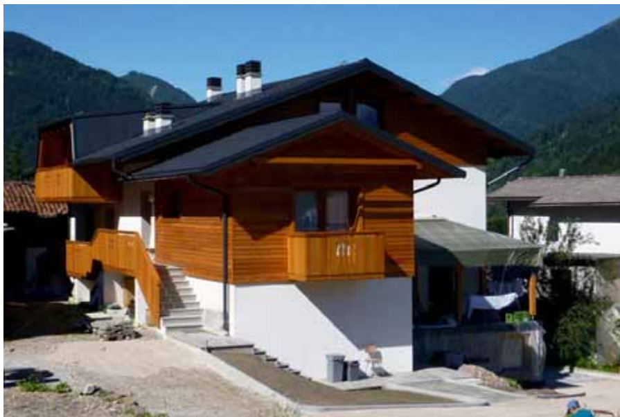
Viste esterne preesistente e post intervento
