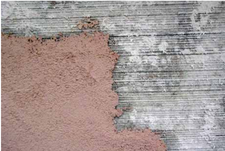
Intonaco alleggerito in perlite su rete zincata
