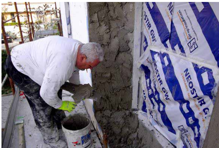
Intonacatura termoisolante strombature
