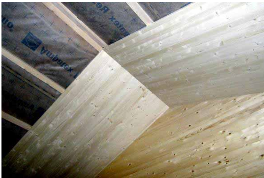
Volume X-lam, pannelli controsoffitto sotto telo
