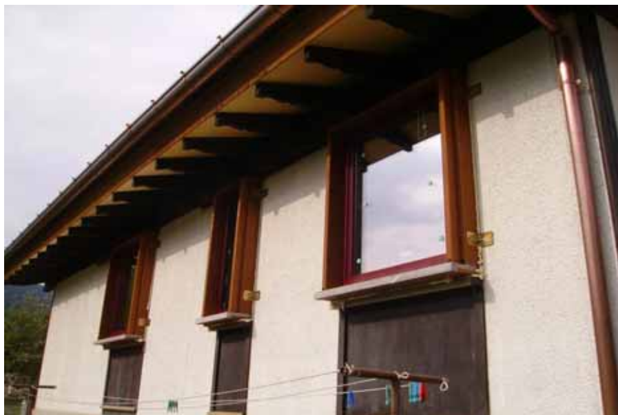
Alloggiamento finestre monoblocco a sbalzo
