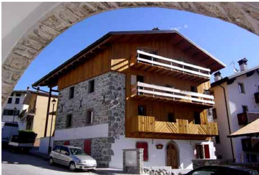
Viste esterne preesistente e post intervento
