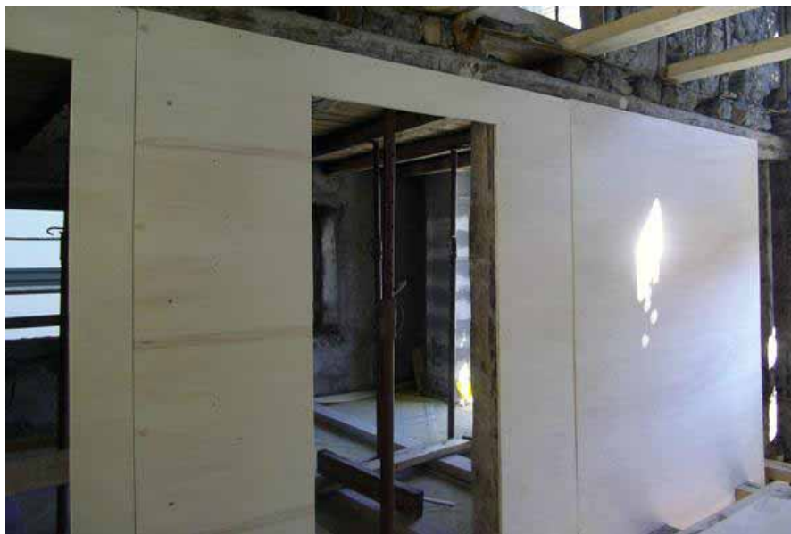
Pannelli di compensato irrigidenti muri intelaiati
