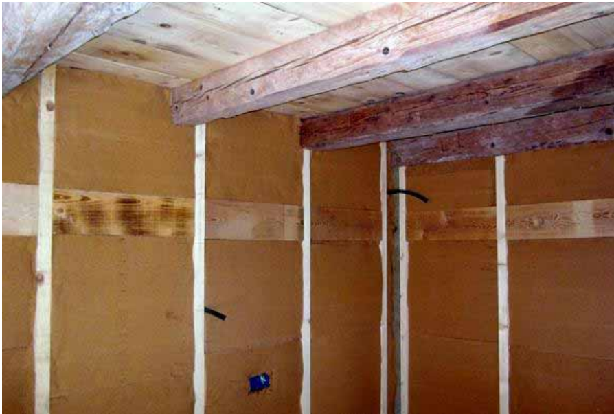
1/3 Isolamento intercapedine impiantistica
