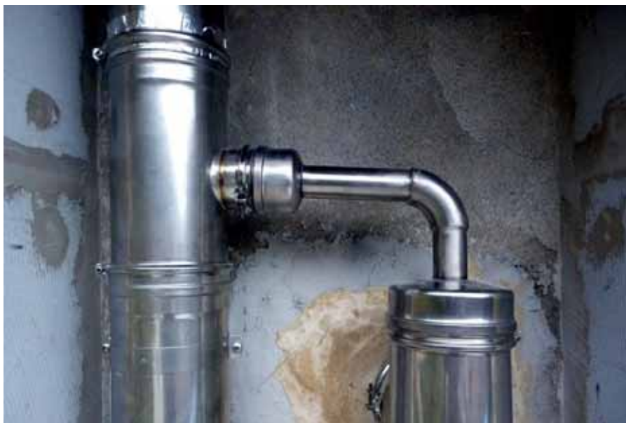
Girofumi con serpentine scambiatore ACS
