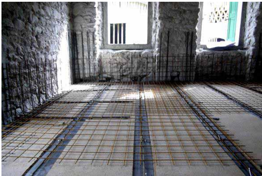
Armature incrociate e passanti interpiano
