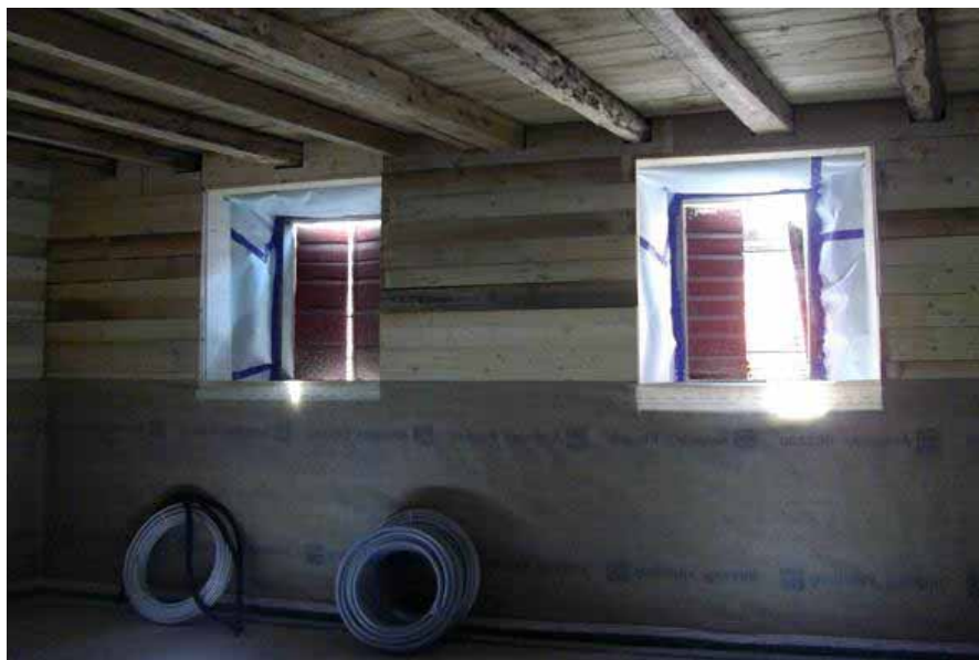
Contropareti perimetrali a cassero in legno
