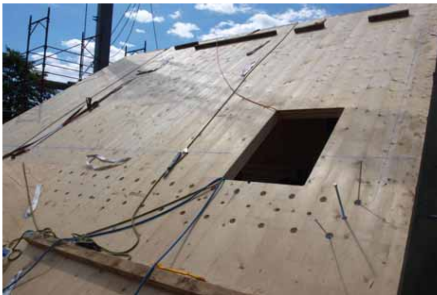
Pannelli di copertura in X-lam con fissaggi
