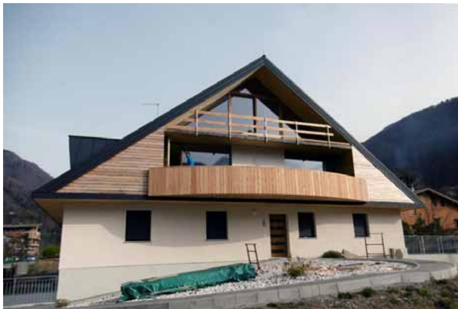
Viste esterne preesistente e post intervento
