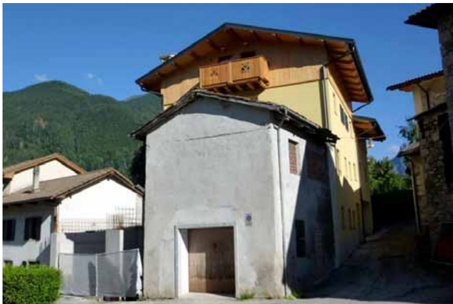
Viste esterne preesistente e post intervento
