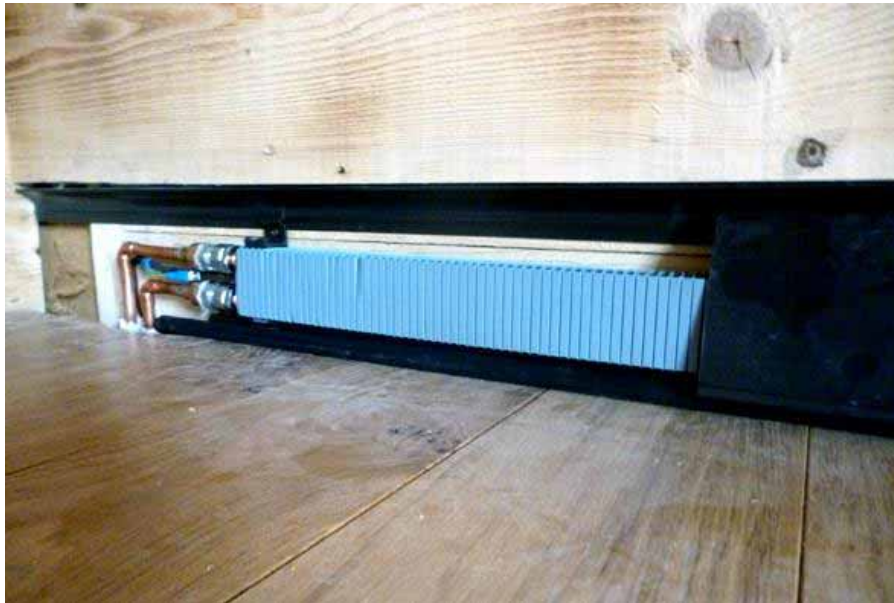
Battiscopa radiante ad acqua ed elettricità
