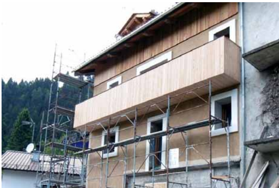
Viste esterne preesistente e di cantiere
