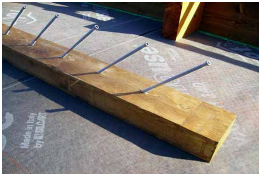
Rinforzo legno-legno travi di copertura
