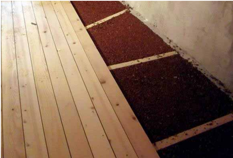
Sottofondi a secco in sughero granulare
