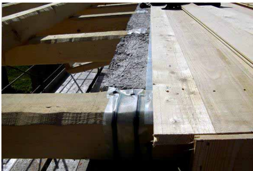
Guarnizioni passa travi lignee a tenuta all'aria
