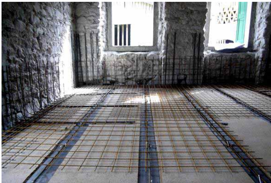
Armature incrociate e passanti interpiano
