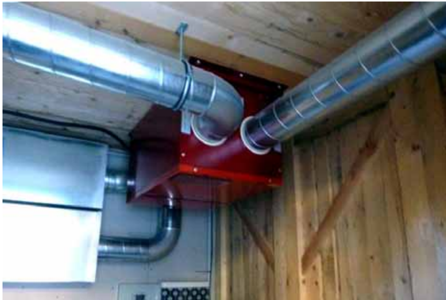
VMC entalpica senza batteria antigelo
