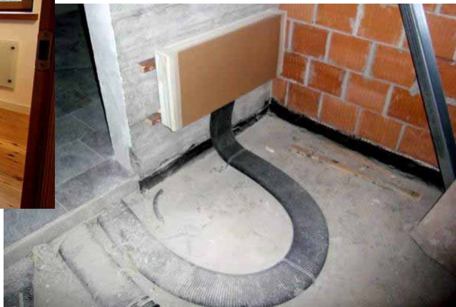
Distributori VMC con riscaldatori integrati
