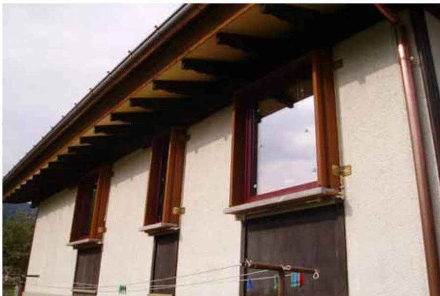
Alloggiamento finestre monoblocco a sbalzo
