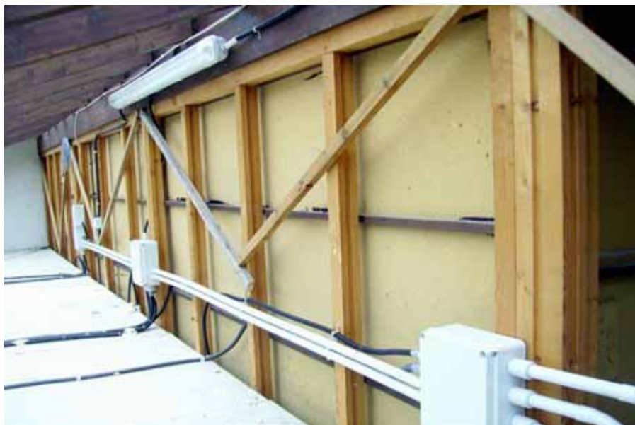
Sistema intelaiato da 75 mm di spessore
