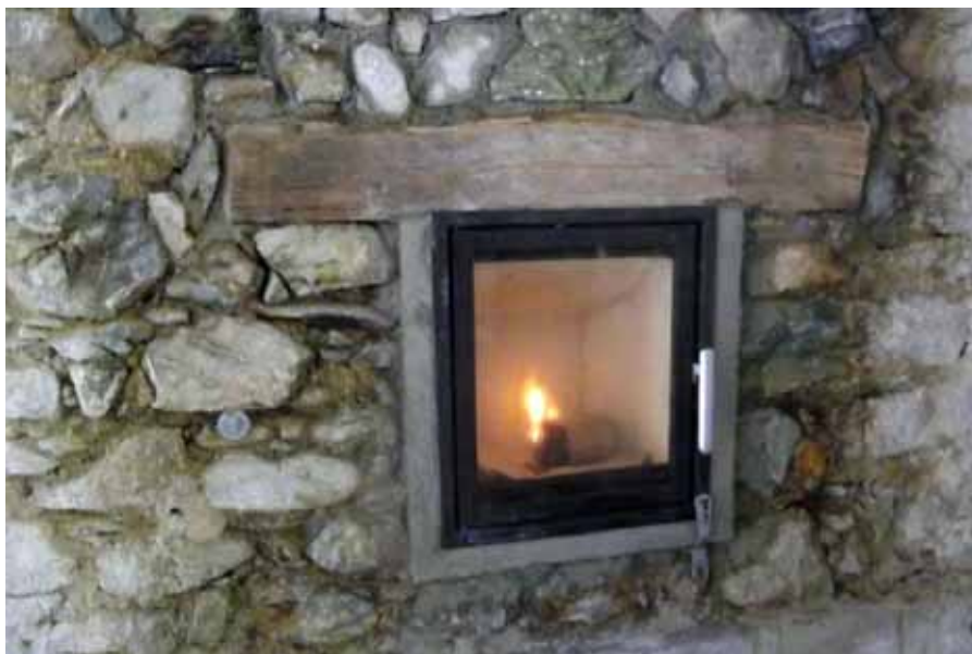
Inserto ad accumulo entro muro in pietrame
