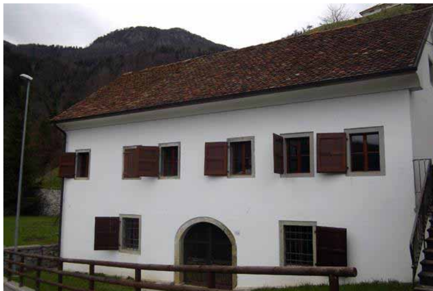
Viste esterne preesistente e post intervento
