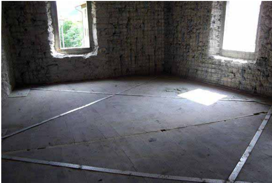
Nastri metallici di controventamento in piano
