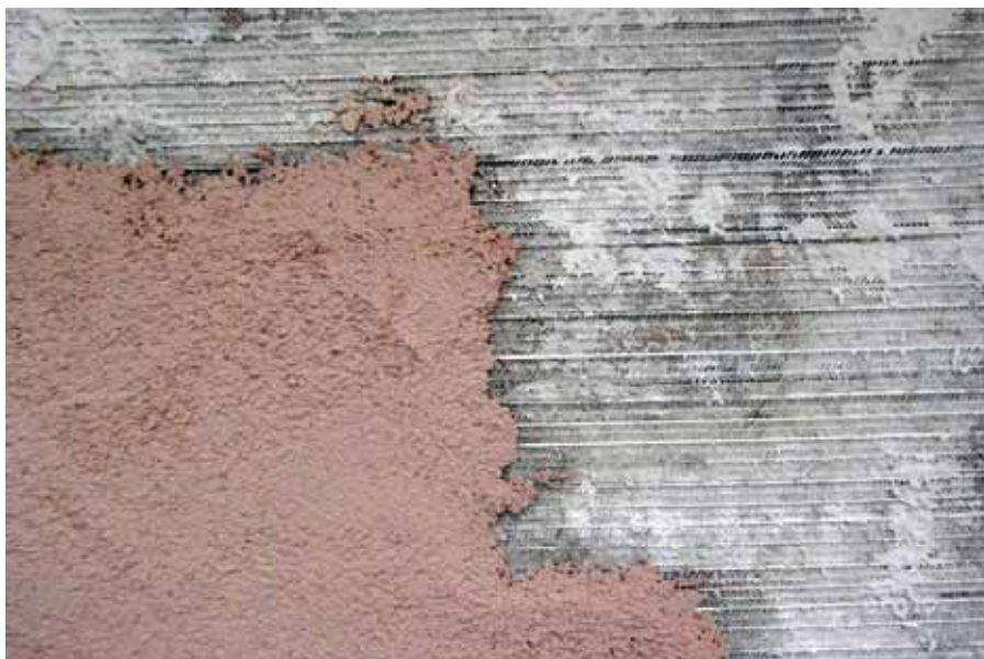
Intonaco alleggerito in perlite su rete zincata
