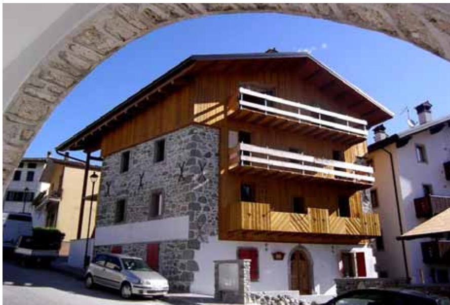
Viste esterne preesistente e post intervento
