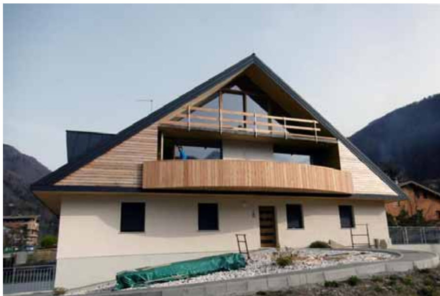
Viste esterne preesistente e post intervento
