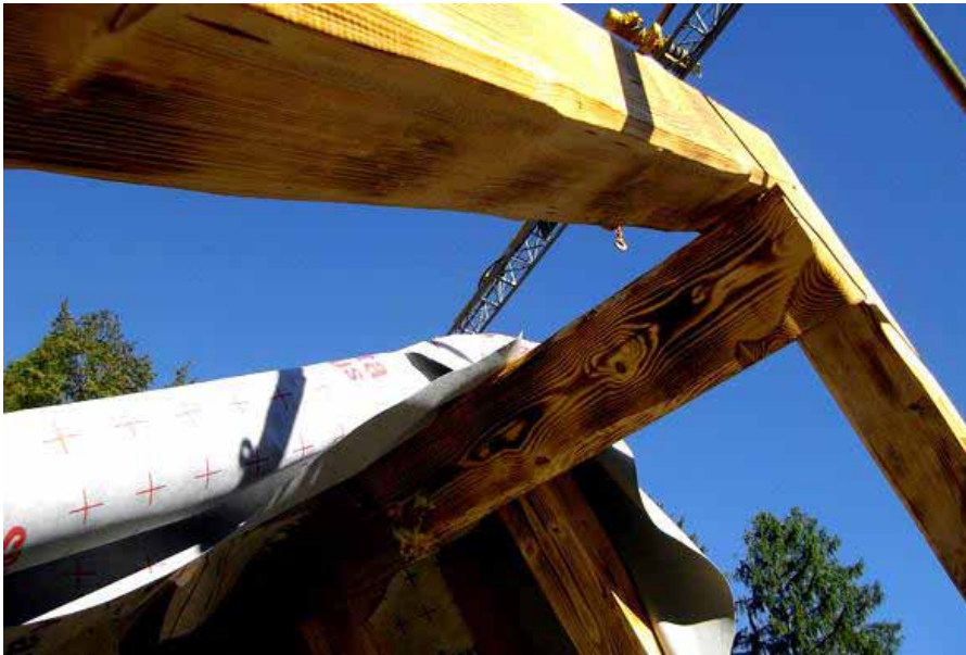
Allungamento trave colmo con barre resinate
