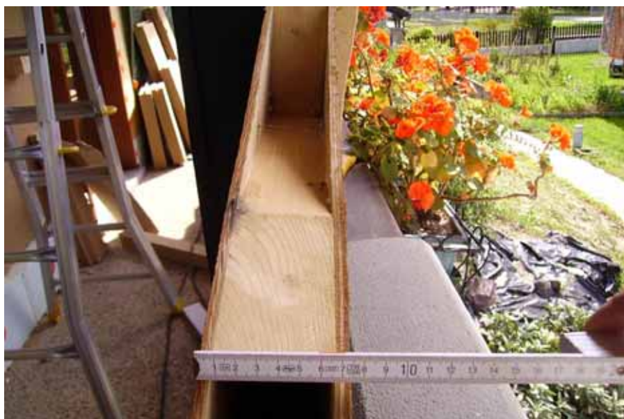
Sistema intelaiato da 75 mm di spessore
