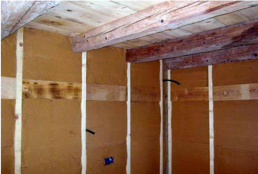
1/3 Isolamento intercapedine impiantistica
