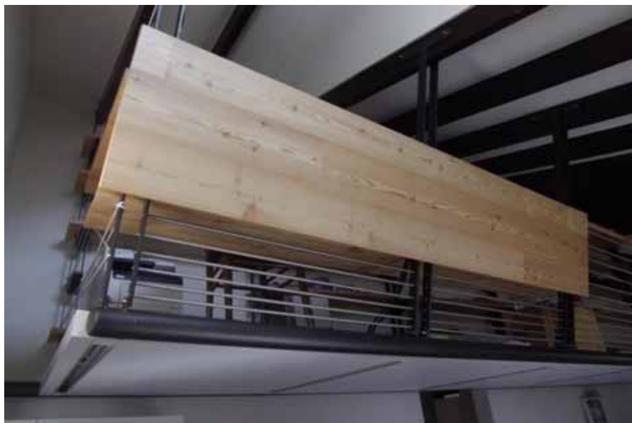
Soppalco interno appeso alle travi rinforzate
