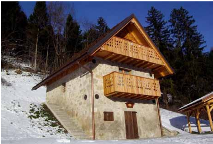
Viste esterne preesistente e post intervento
