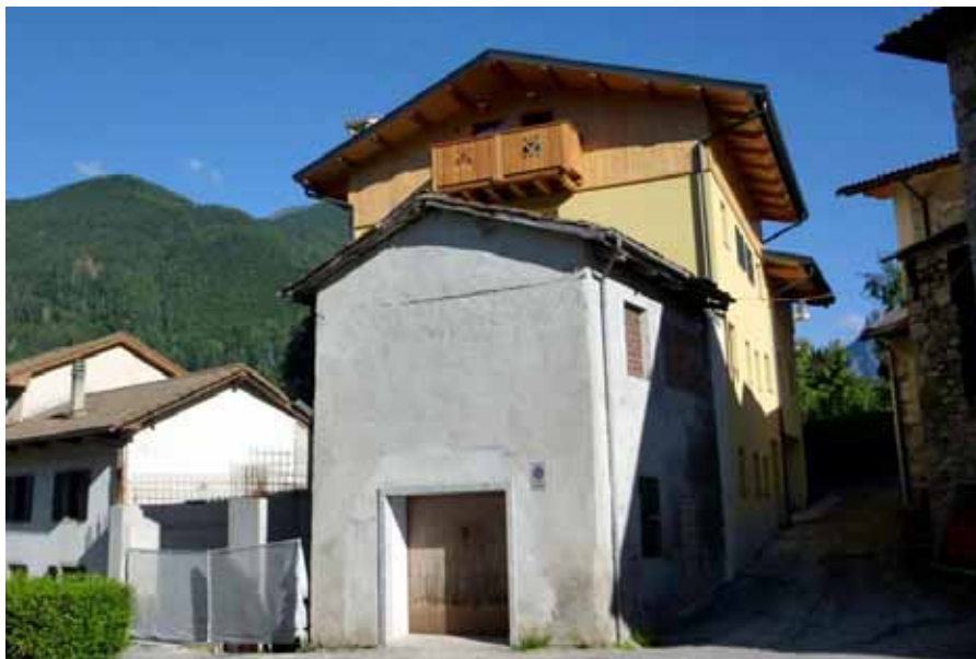
Viste esterne preesistente e post intervento
