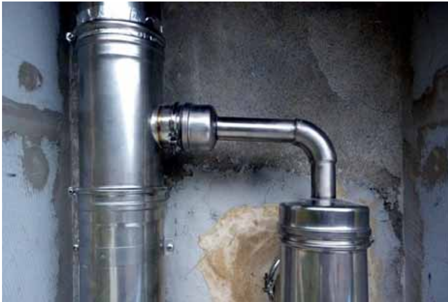
Girofumi con serpentine scambiatore ACS
