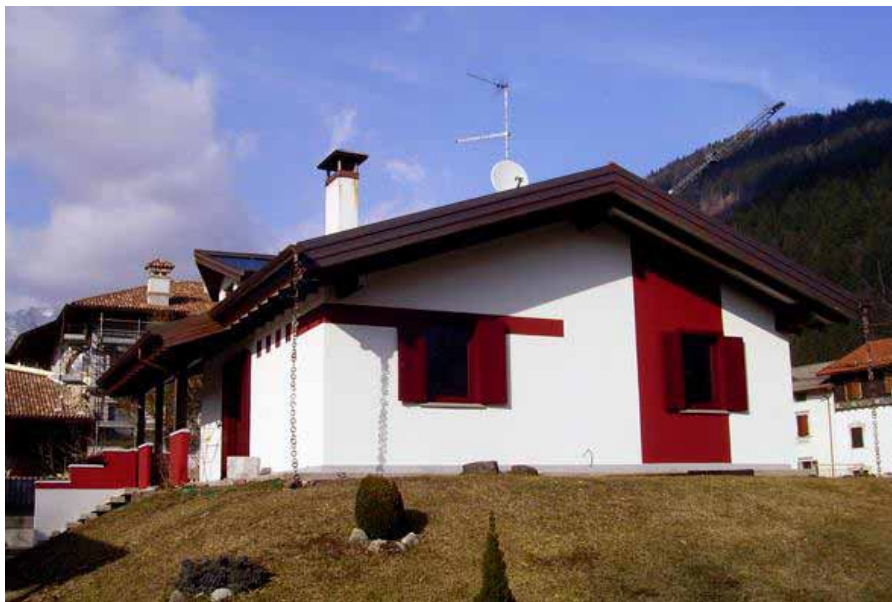
Viste esterne preesistente e post intervento
