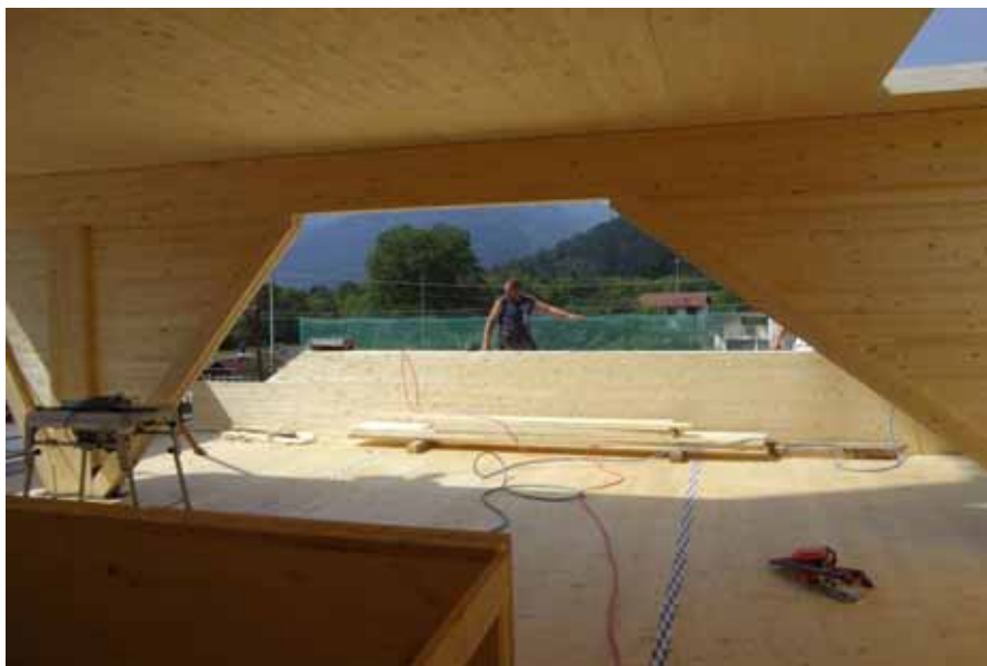
Coppia telai in L.L. reggi solaio mansarda
