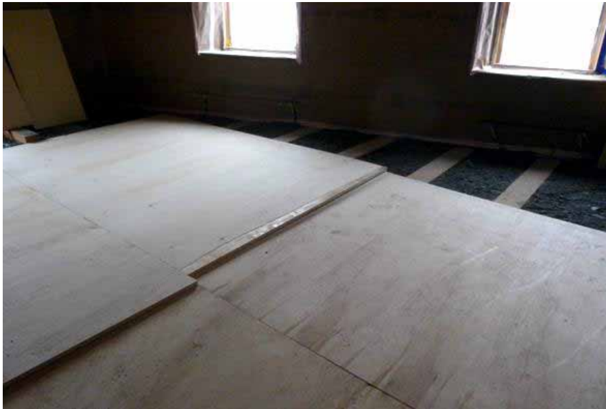
Travi collaboranti legno-legno di rinforzo solai
