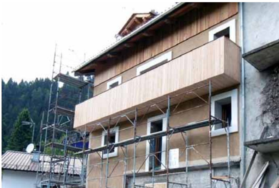
Viste esterne preesistente e di cantiere
