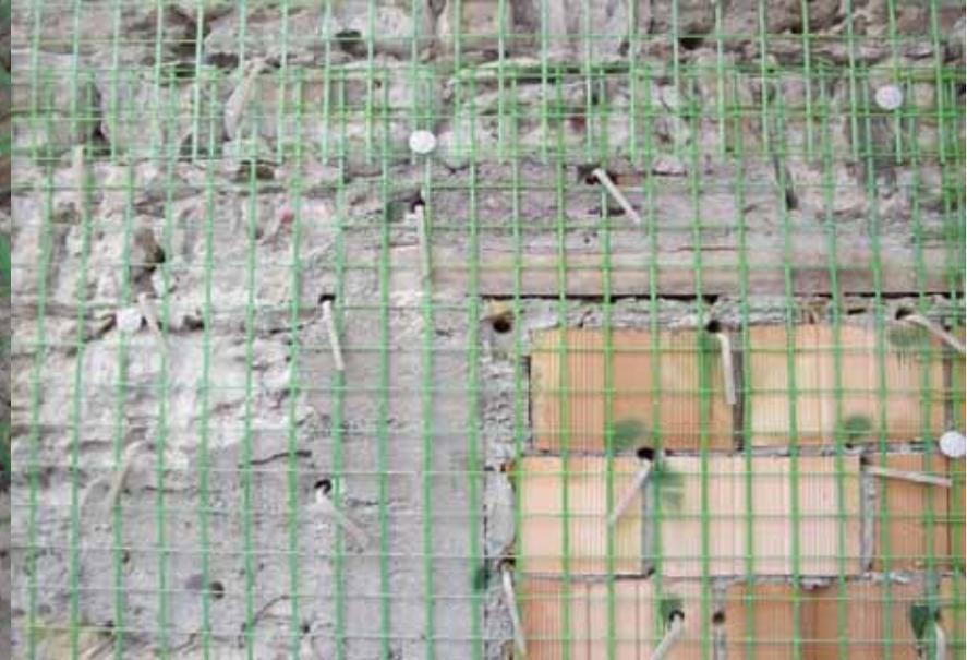
**Murature portanti: Consolidamento con betoncino a base di calce e pozzolana e rete in F.R.P.**
