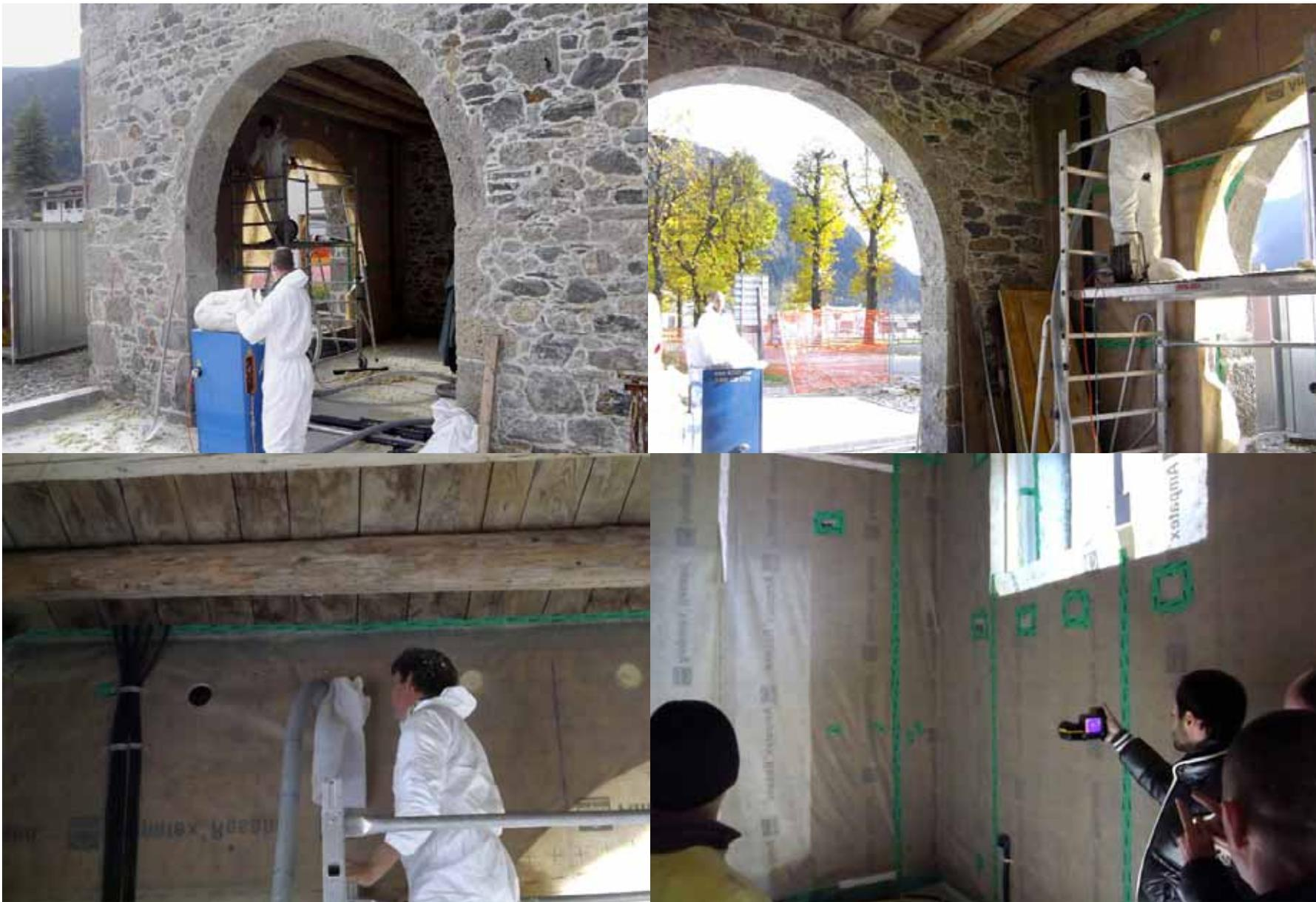
**Coibentazione interna pareti: Isolamento ad intercapedine tramite insufflaggio di cellulosa**
