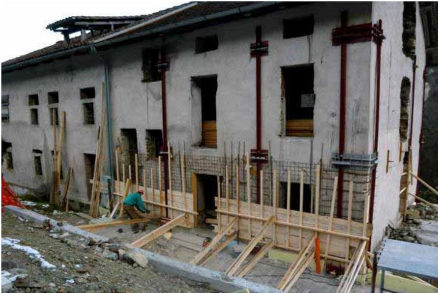
Inglobamento telai metallici entro betoncini
