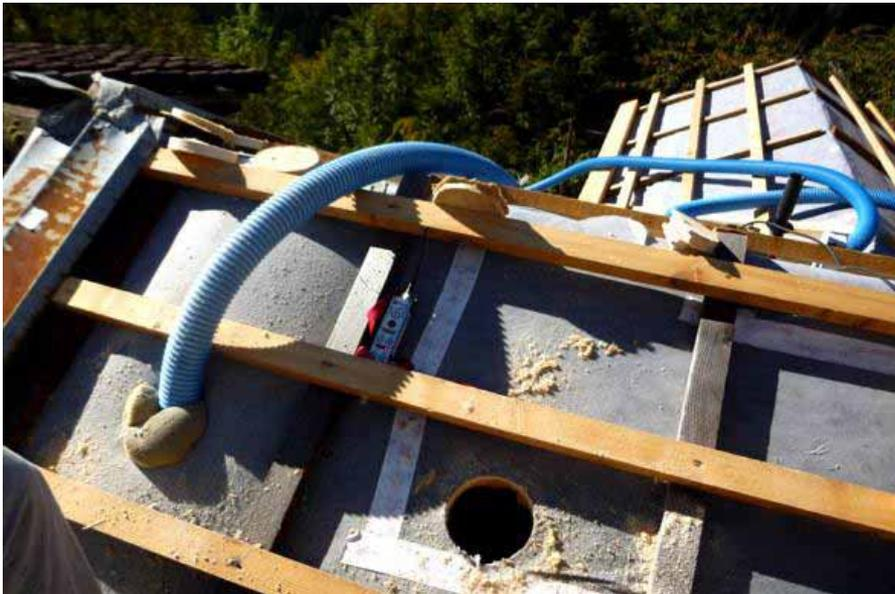
Insufflaggio cellulosa ad alta pressione 80 kg/mc
