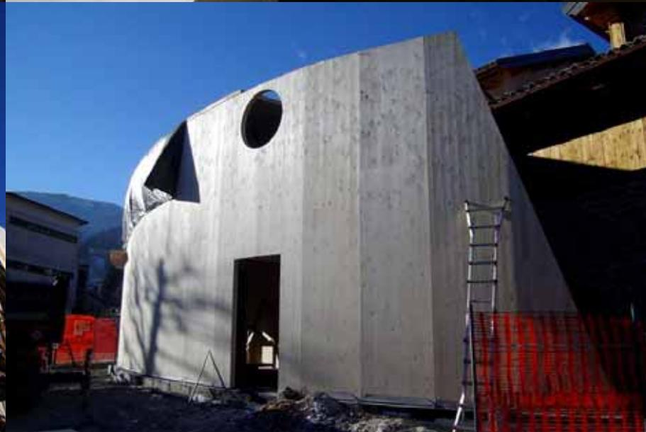
**Blocco servizi in X-lam: isolamenti in fibre di legno ed irrigidimento pareti non isolate**
