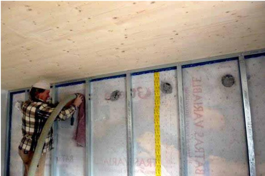
Insufflaggio cellulosa alta densità 80 kg/mc
