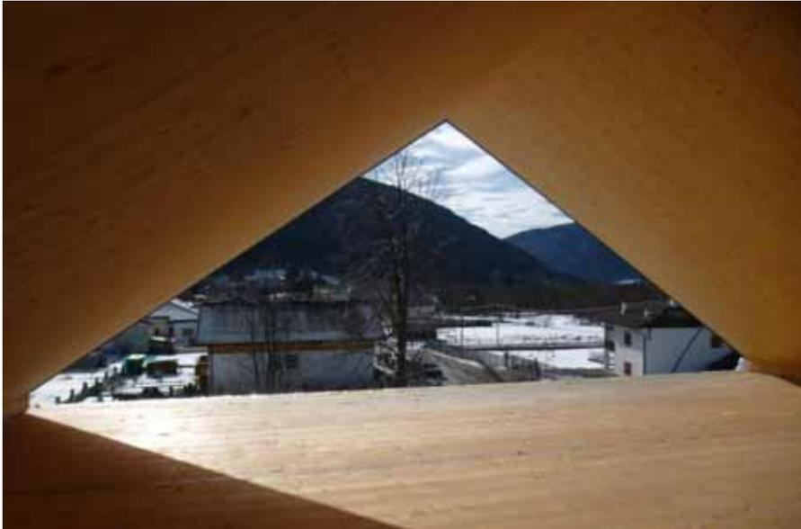
Copertura X-lam a vista con isolamento esterno
