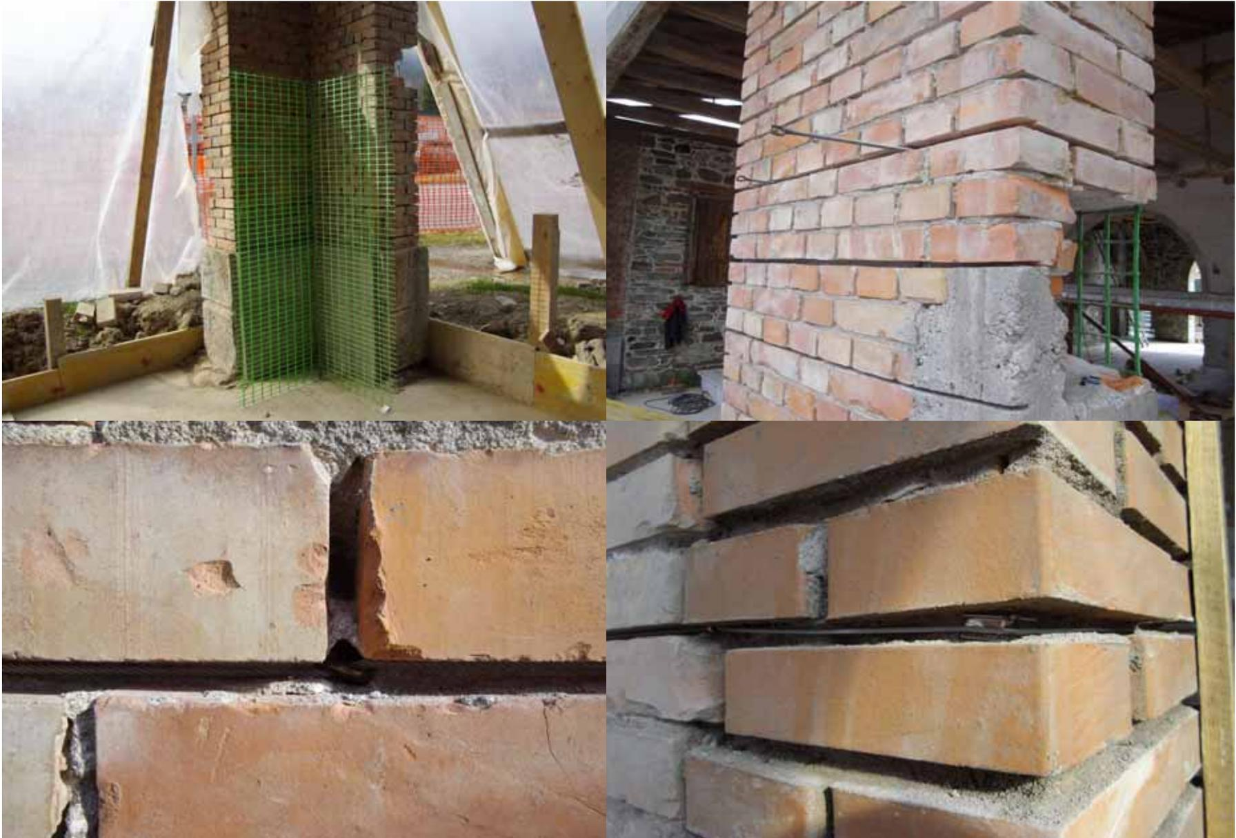
**Pilastrini in mattoni: Consolidamento con betoncino a base di calce e sistema "Reticulatus"**
