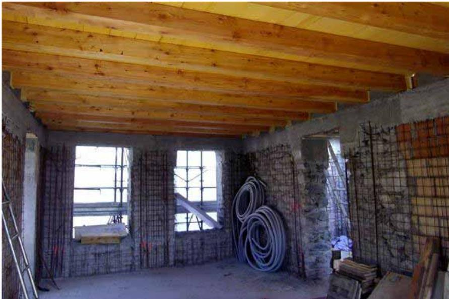
Armature unite betoncini muri e cappe solai
