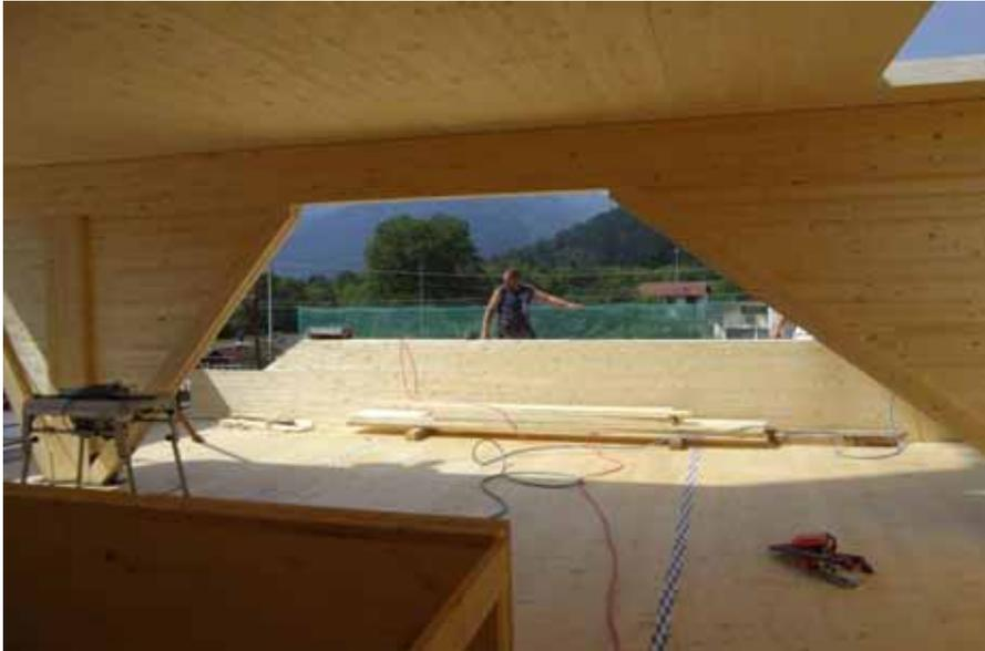
Coppia telai in L.L. reggi solaio mansarda
