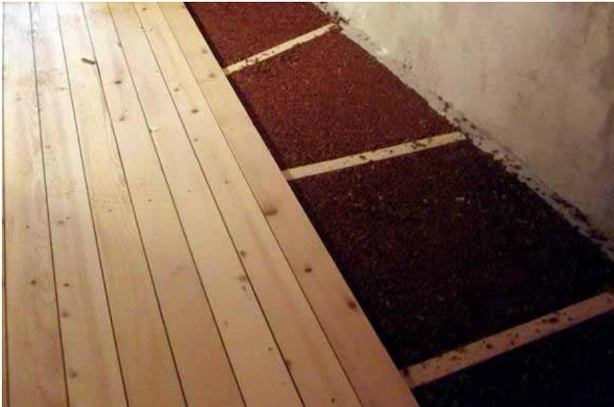
Sottofondi a secco in sughero granulare
