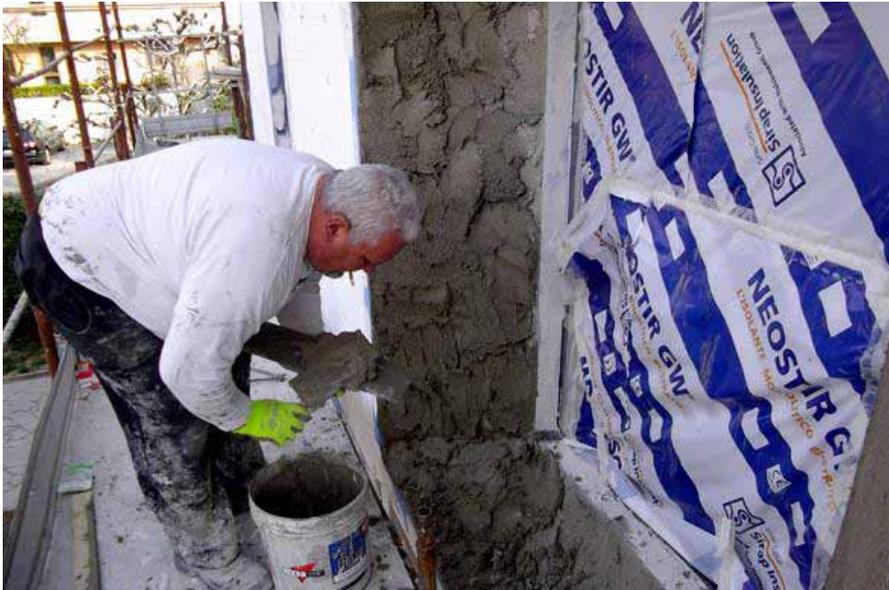
Intonacatura termoisolante strombature
