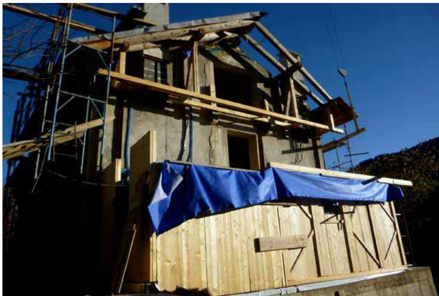
Viste esterne preesistente e di cantiere
