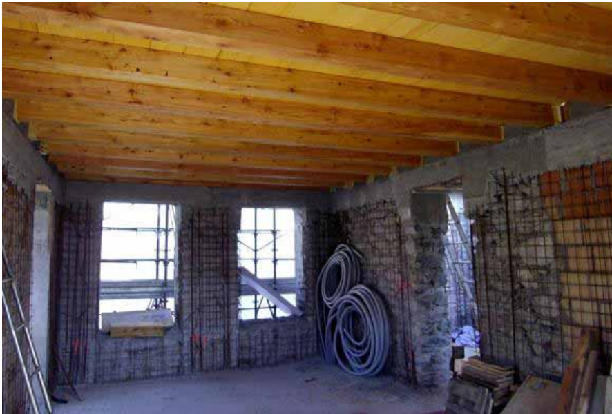
Armature unite betoncini muri e cappe solai
