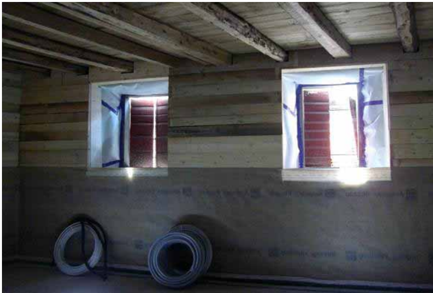
Contropareti perimetrali a cassero in legno
