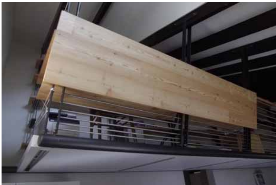
Soppalco interno appeso alle travi rinforzate
