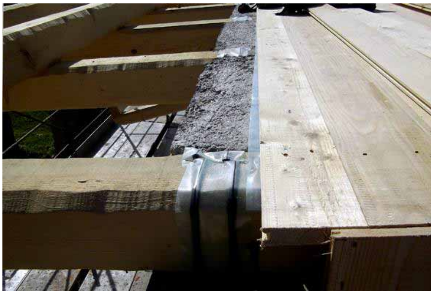
Guarnizioni passa travi lignee a tenuta all'aria
