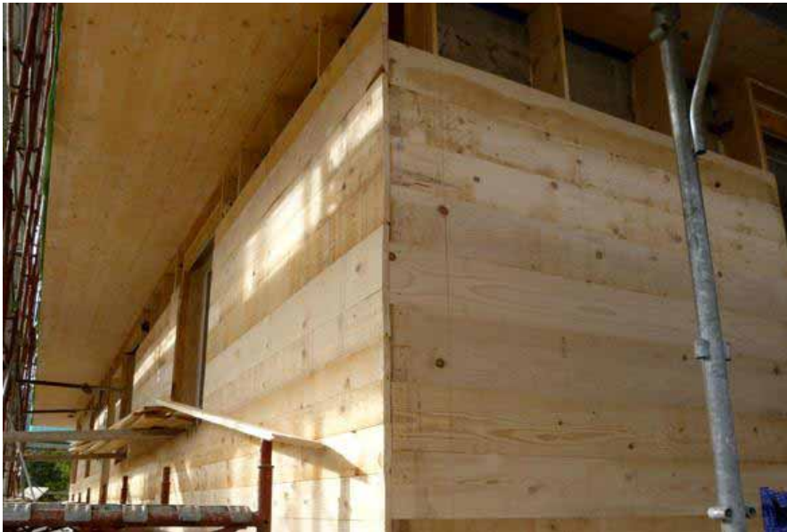
Realizzazione casseri lignei sulle murature
