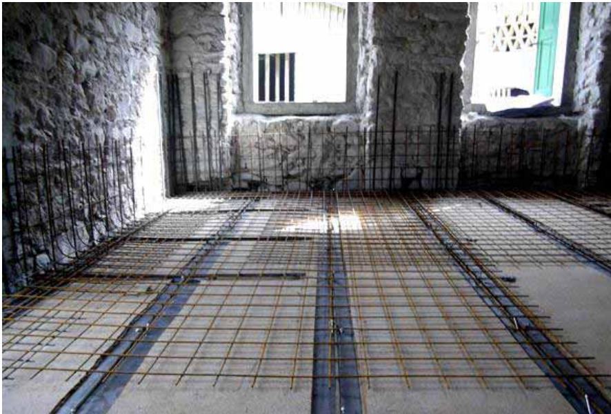
Armature incrociate e passanti interpiano
