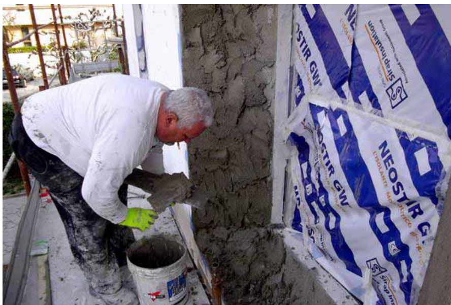
Intonacatura termoisolante strombature
