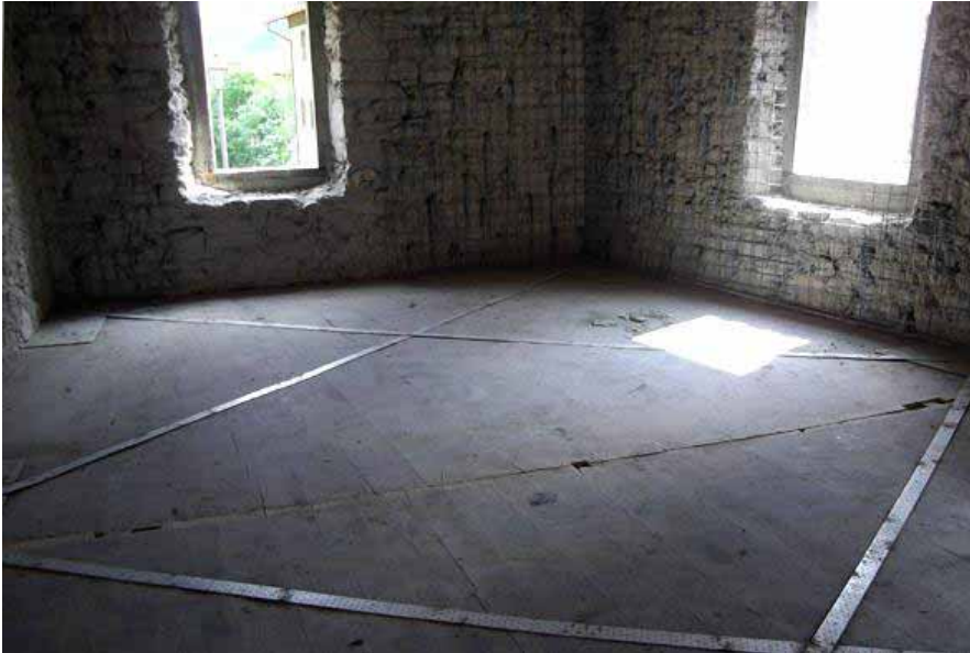
Nastri metallici di controventamento in piano
