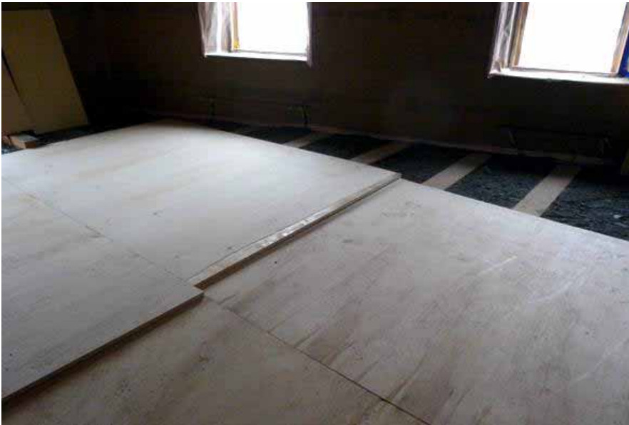
Travi collaboranti legno-legno di rinforzo solai
