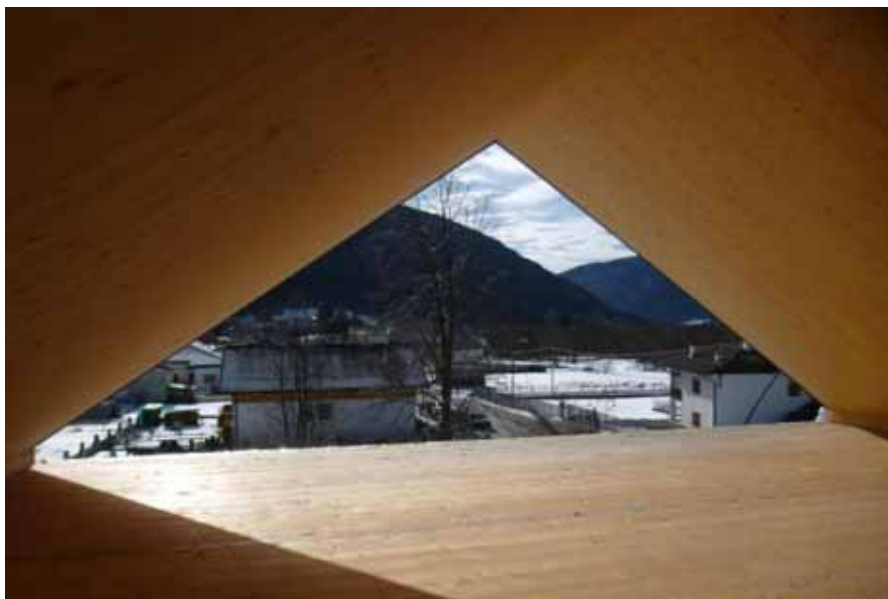
Copertura X-lam a vista con isolamento esterno
