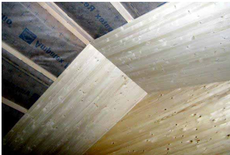
Volume X-lam, pannelli controsoffitto sotto telo
