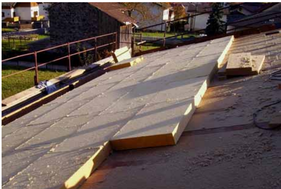
Travetti di rinforzo entro isolamento tetto
