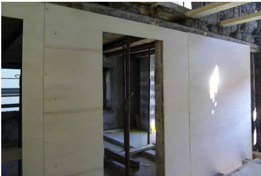
Pannelli di compensato irrigidenti muri intelaiati
