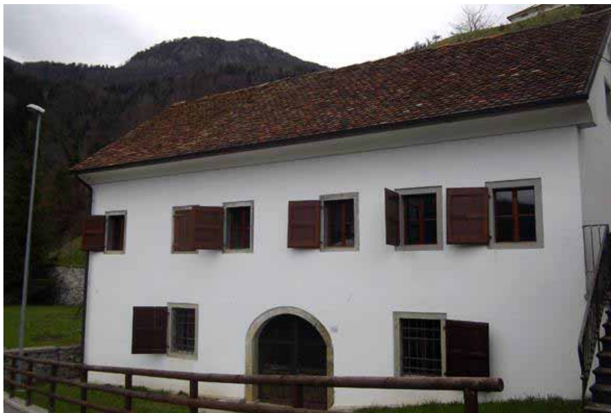
Viste esterne preesistente e post intervento
