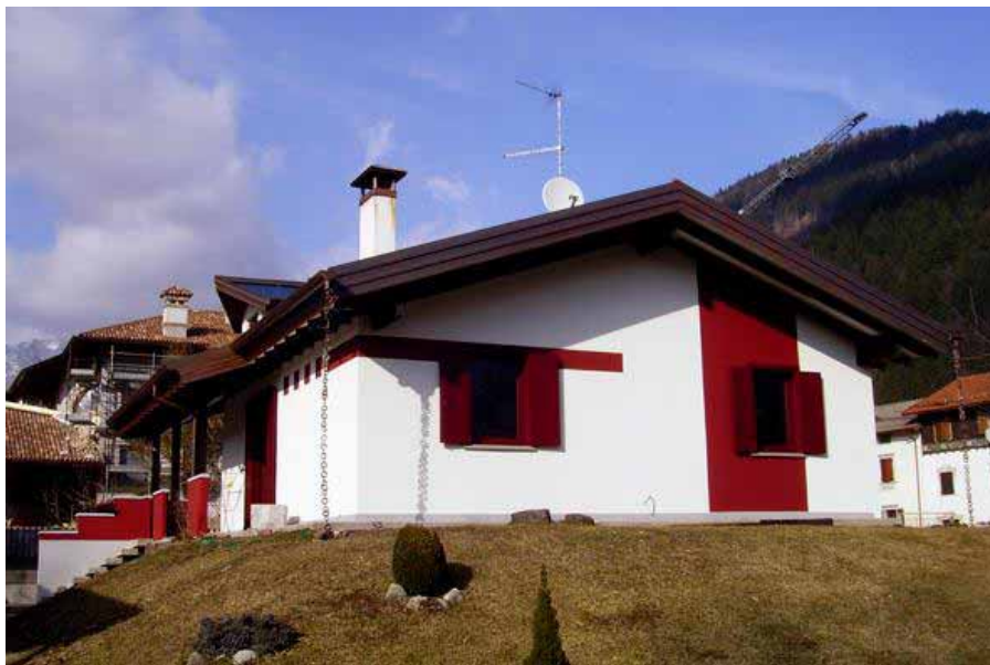
Viste esterne preesistente e post intervento
