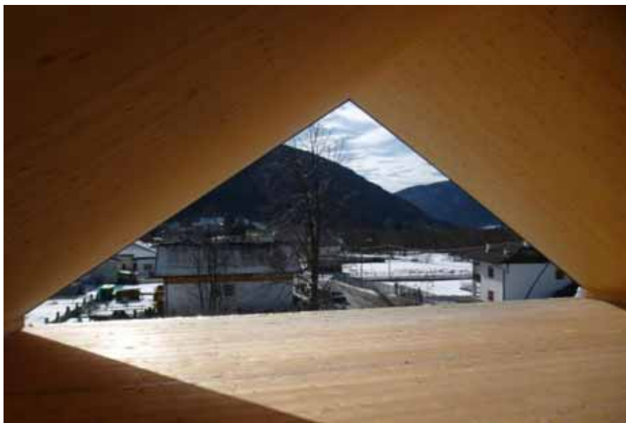
Copertura X-lam a vista con isolamento esterno
