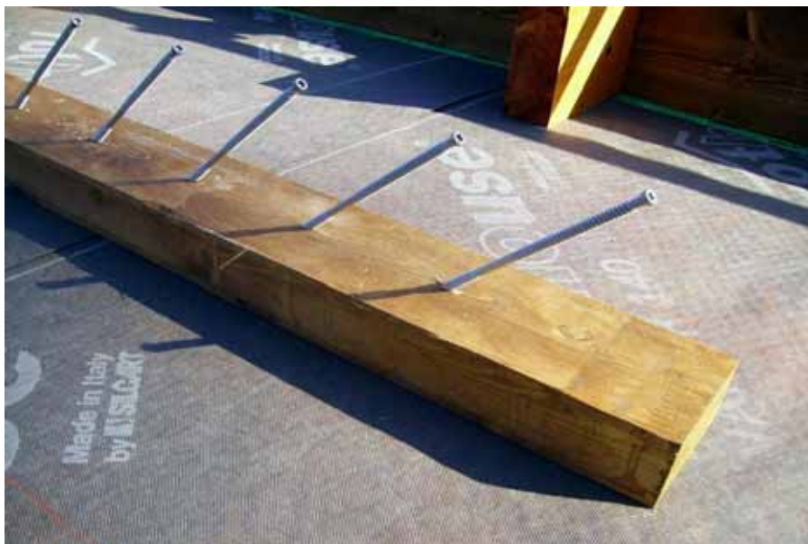
Rinforzo legno-legno travi di copertura
