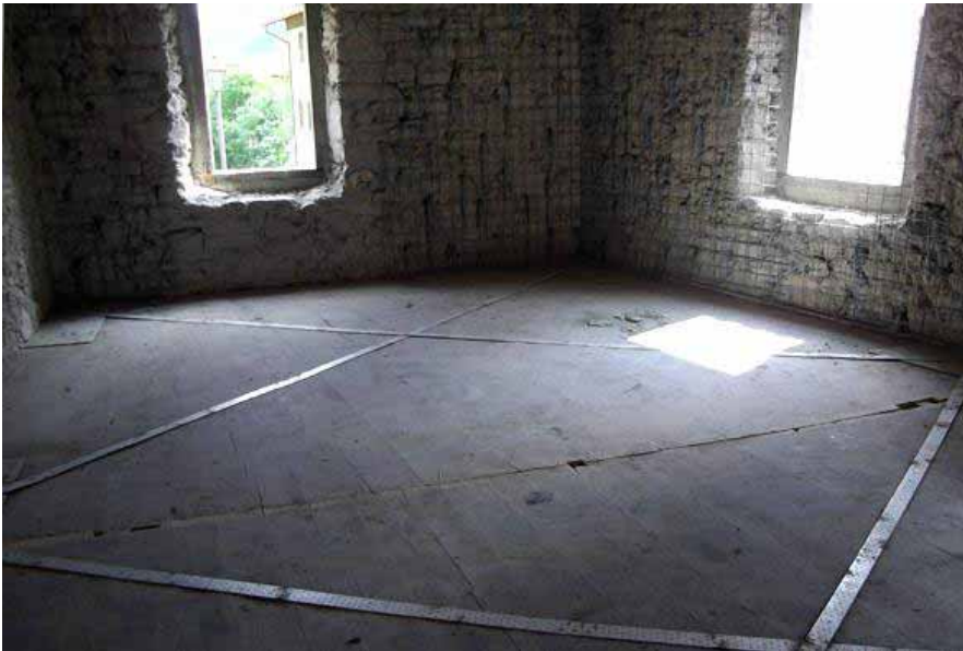
Nastri metallici di controventamento in piano
