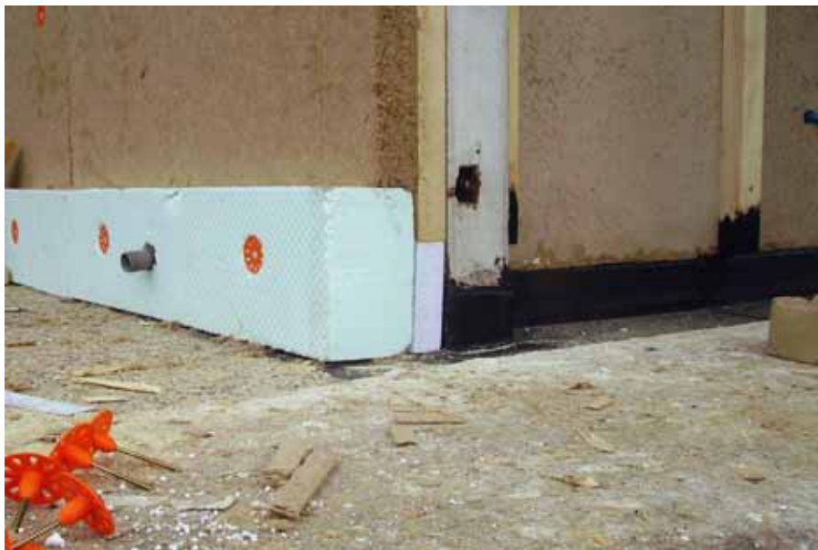
Base di partenza in XPS su guaina liquida
