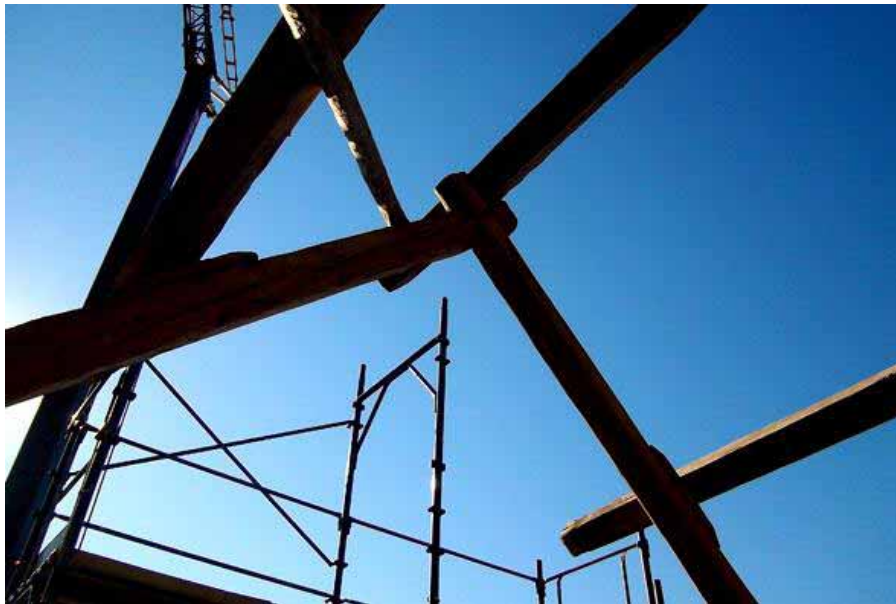
Mantenimento strutture copertura lignea
