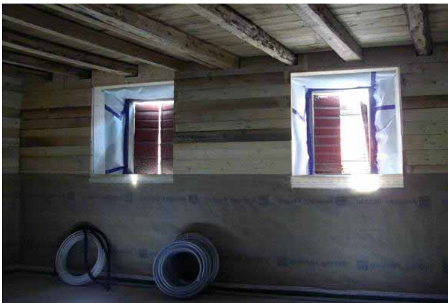
Contropareti perimetrali a cassero in legno
