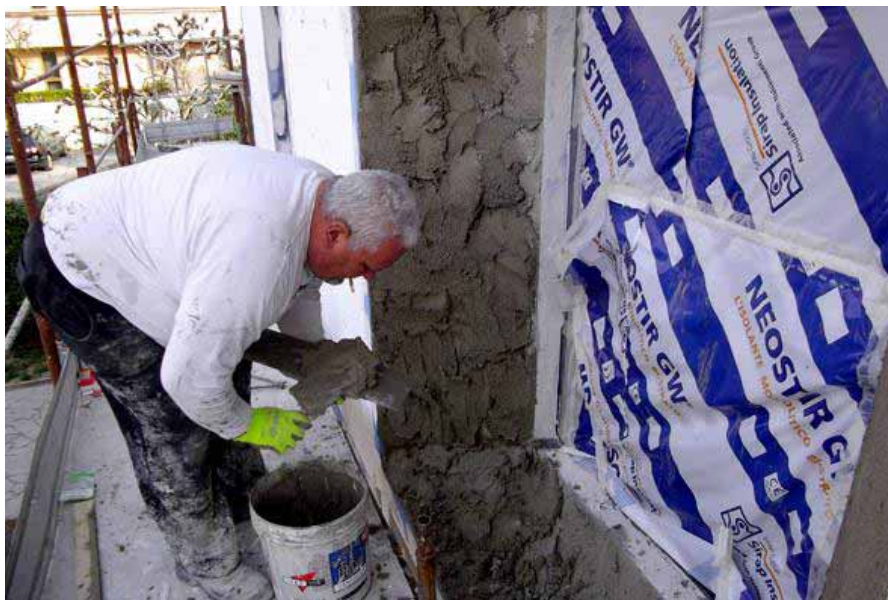
Intonacatura termoisolante strombature
