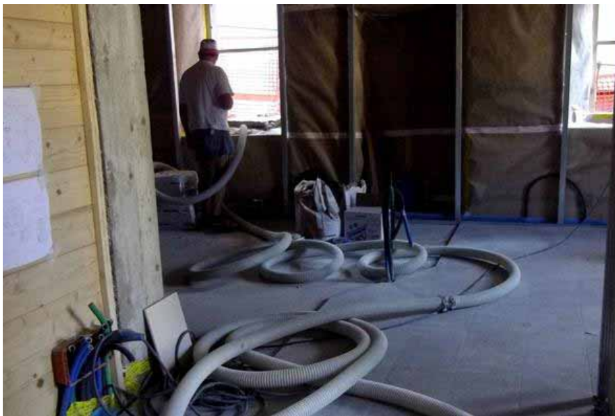
Isolamento insufflato entro casseri in legno
