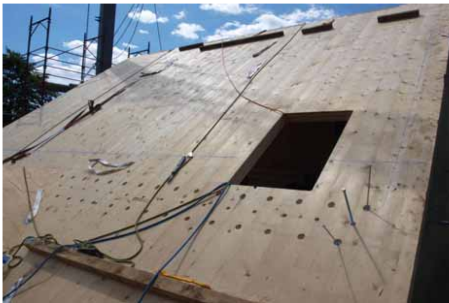
Pannelli di copertura in X-lam con fissaggi
