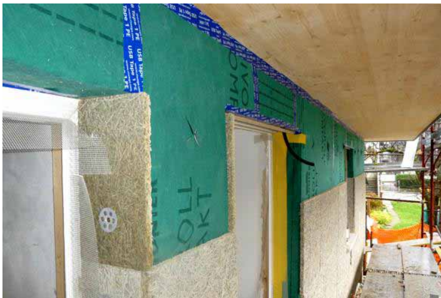
Applicazione pannelli porta intonaco su telo
