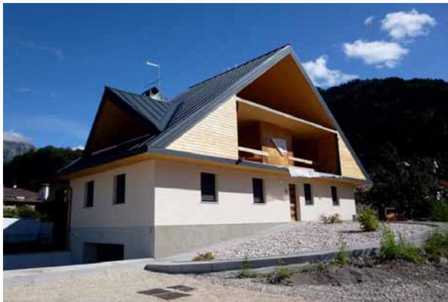
Viste esterne preesistente e post intervento
