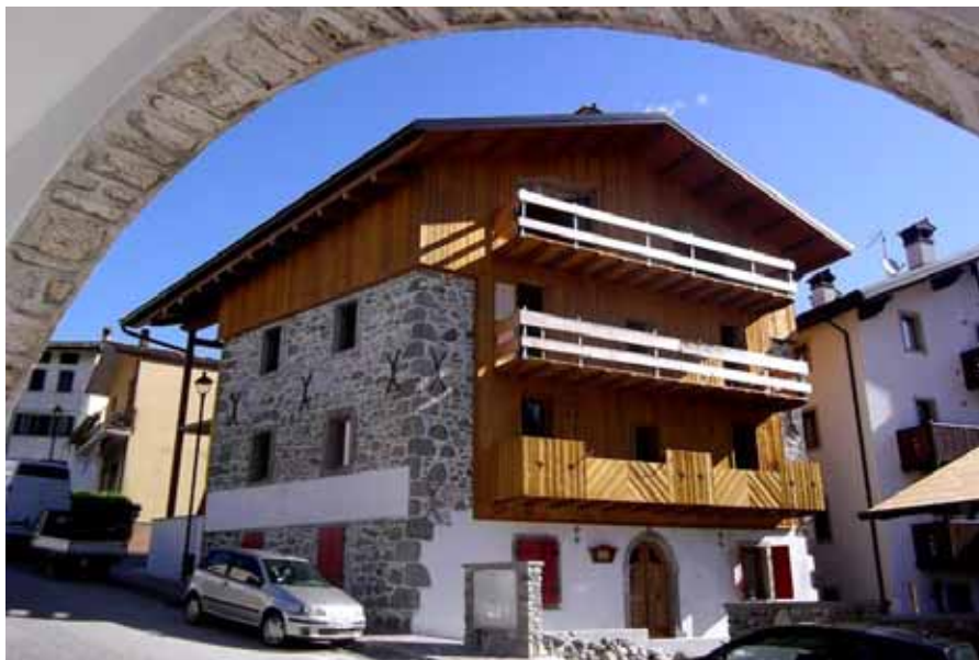
Viste esterne preesistente e post intervento
