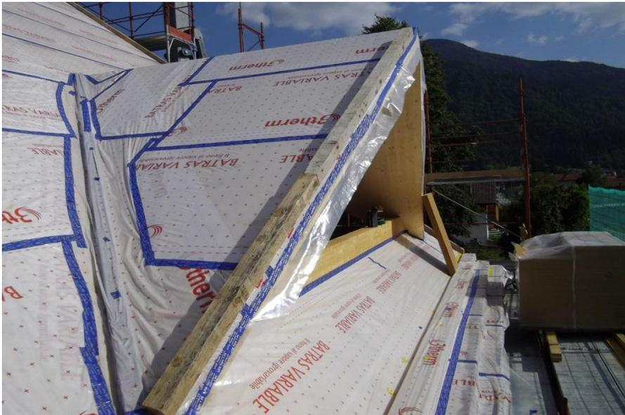
Freno vapore ed isolamento 180 mm
