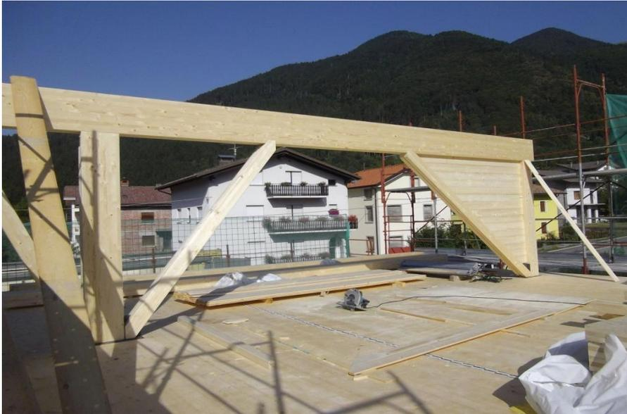
Telaio su primo solaio X-lam 200 mm
