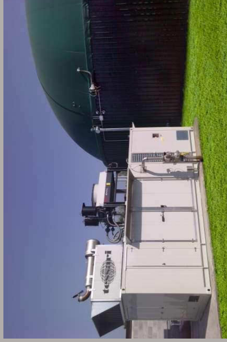
Referenze: Az. Agricola in Cremona: potenza elettrica: 200Kwe potenza termica: 255kWt Digestione anaerobica letame, liquame, sottoprodotti
