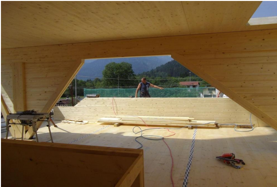
Coppia telai in L.L. reggi solaio mansarda
