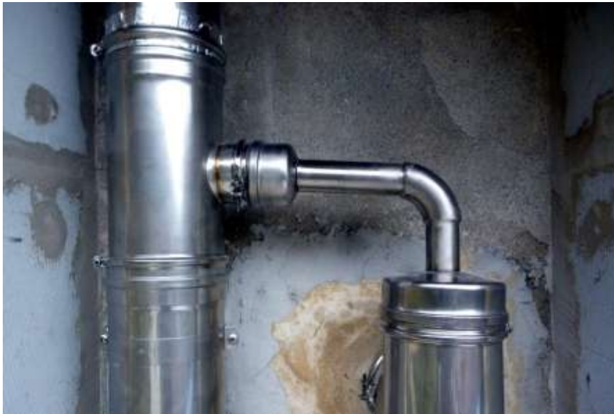
Girofumi con serpentine scambiatore ACS
