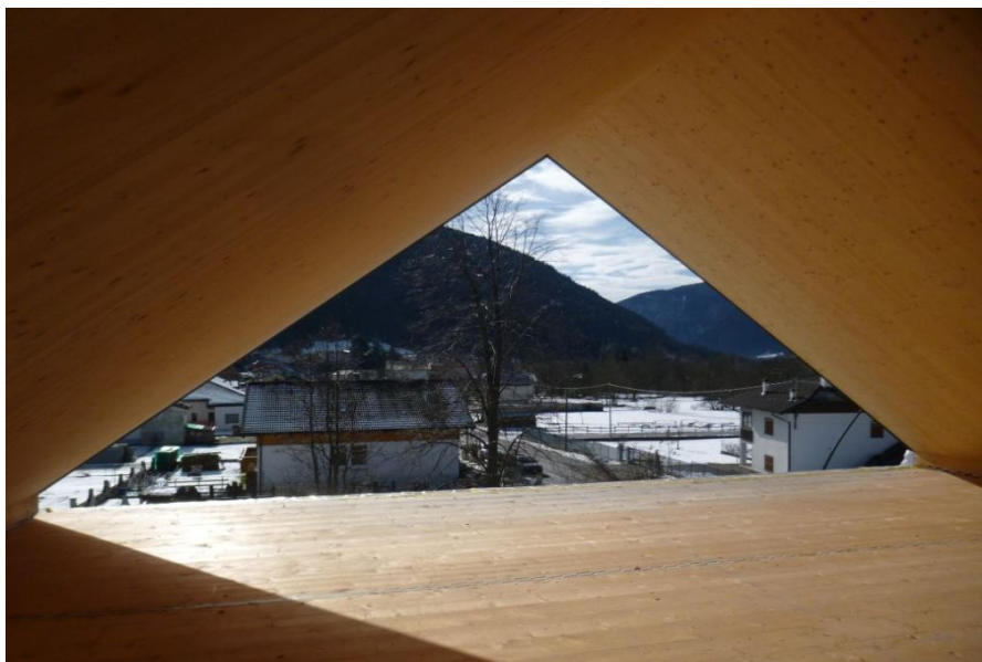
Copertura X-lam a vista con isolamento esterno
