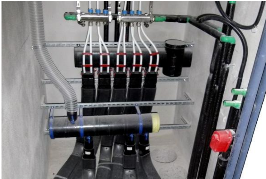
Pompa di calore aria-aria e collettori VMC
