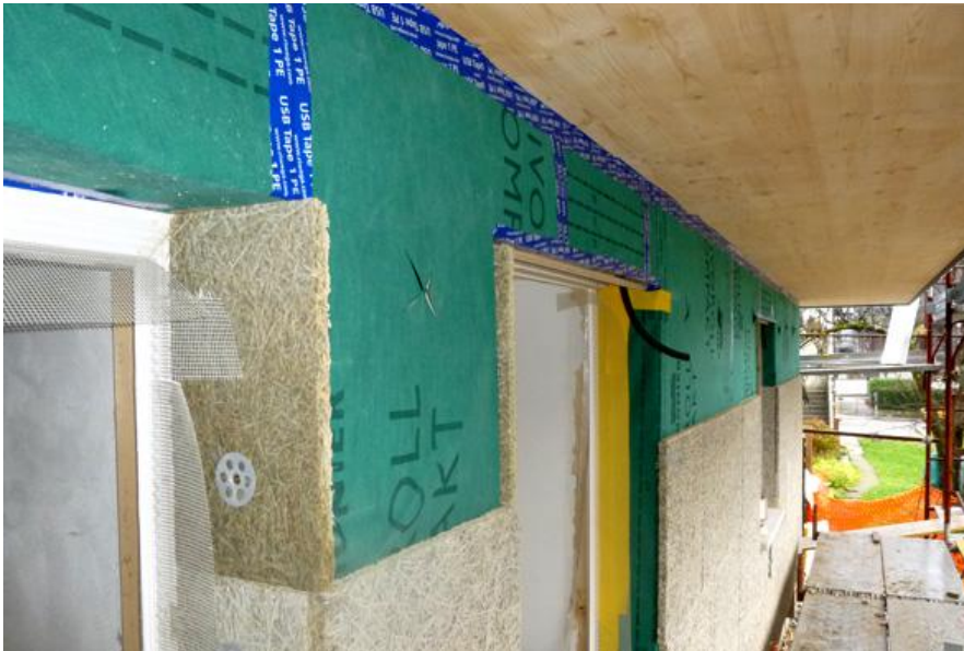
Applicazione pannelli porta intonaco su telo
