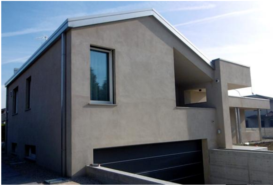
Viste esterne fasi di completamento
