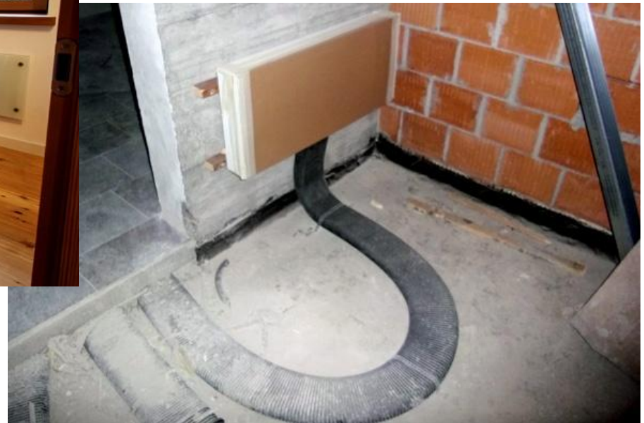
Distributori VMC con riscaldatori integrati
