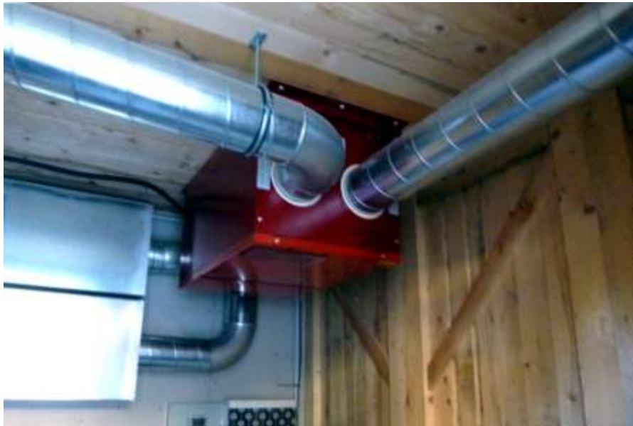
VMC entalpica senza batteria antigelo
