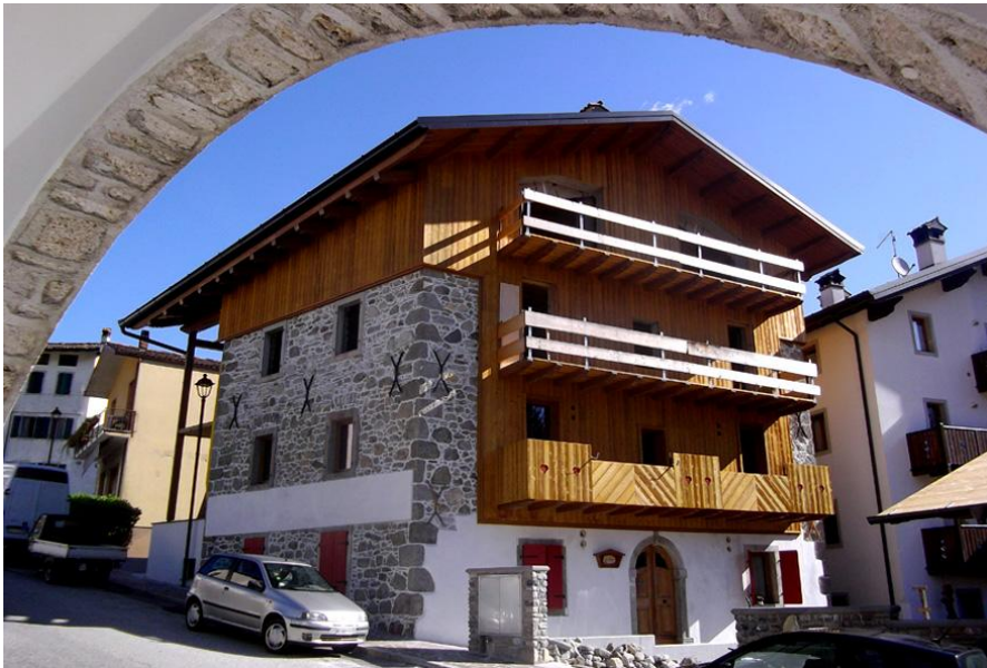
Viste esterne preesistente e post intervento
