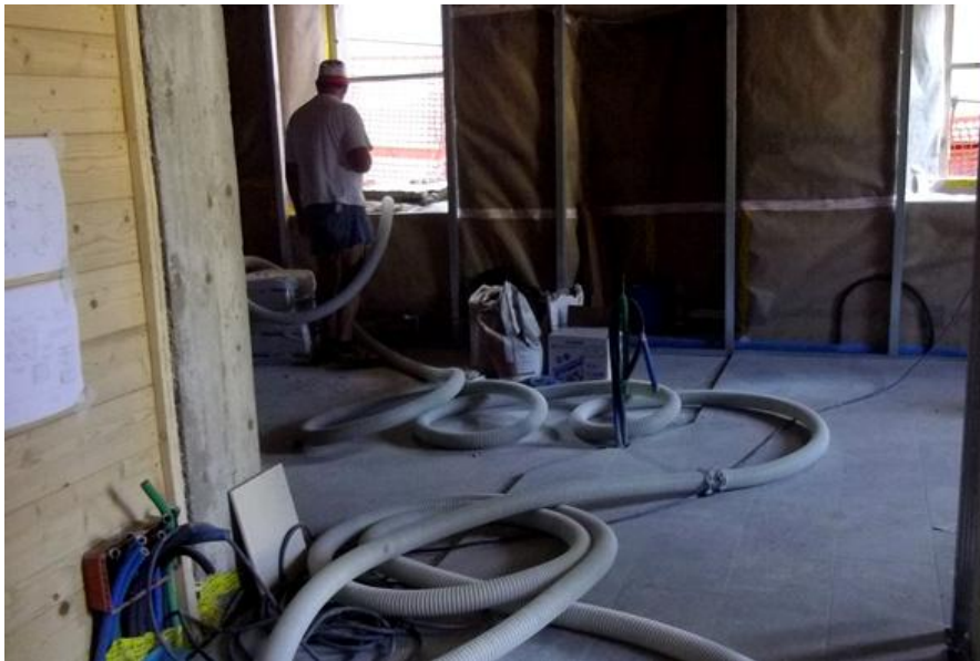
Isolamento insufflato entro casseri in legno
