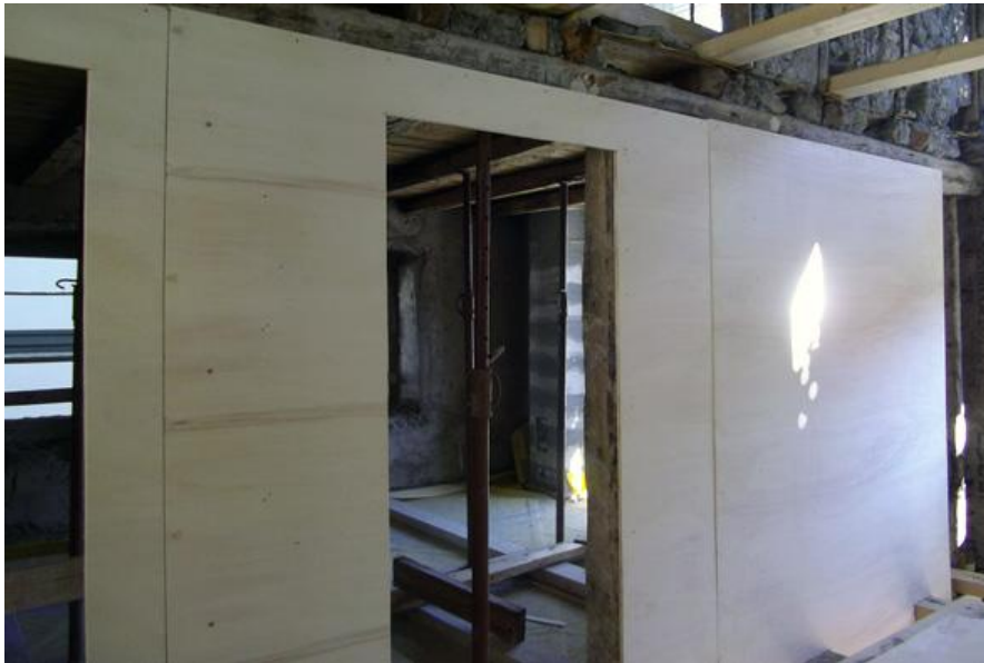
Pannelli di compensato irrigidenti muri intelaiati
