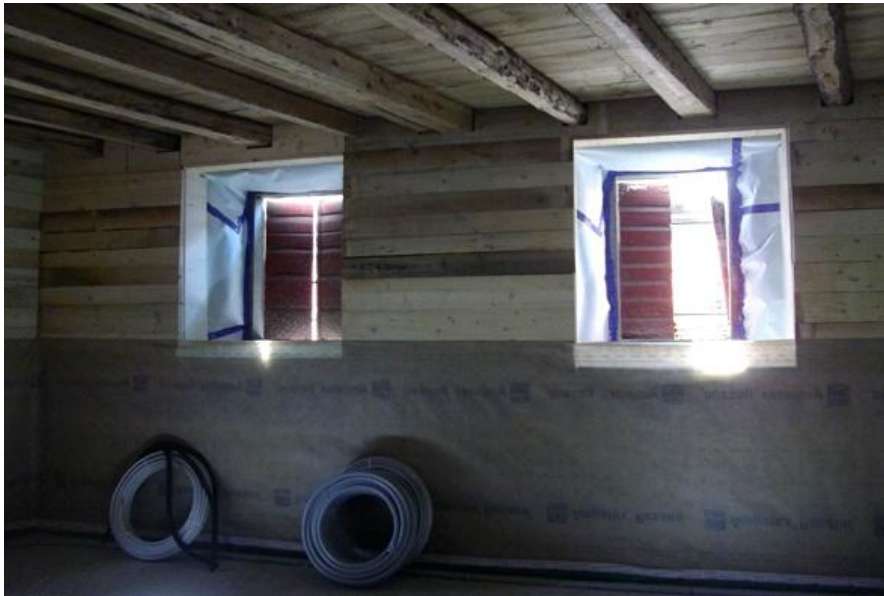
Contropareti perimetrali a cassero in legno
