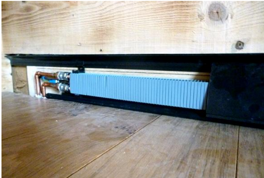
Battiscopa radiante ad acqua ed elettricità
