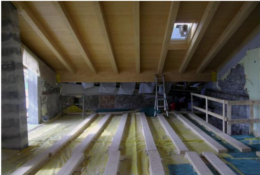
Travi collaboranti legno-legno di rinforzo solai
