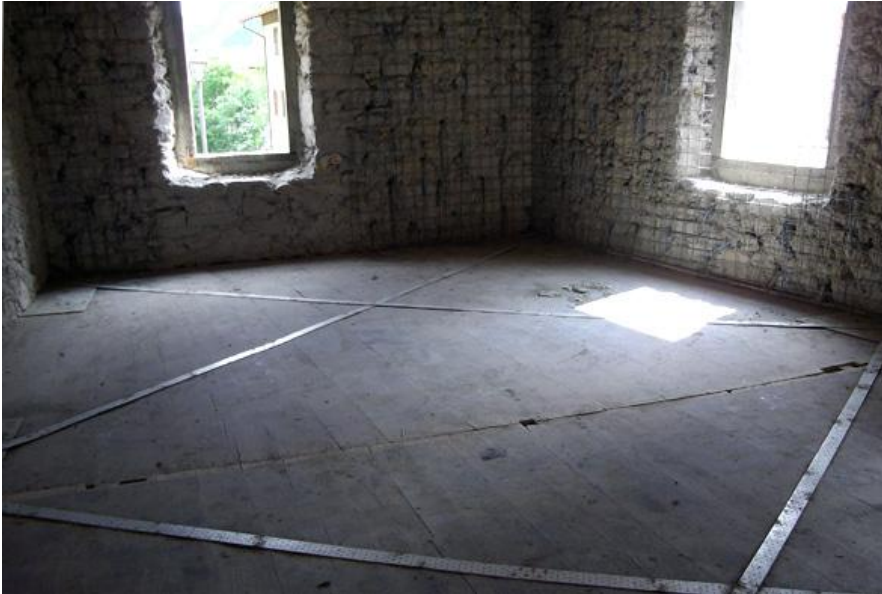
Nastri metallici di controventamento in piano
