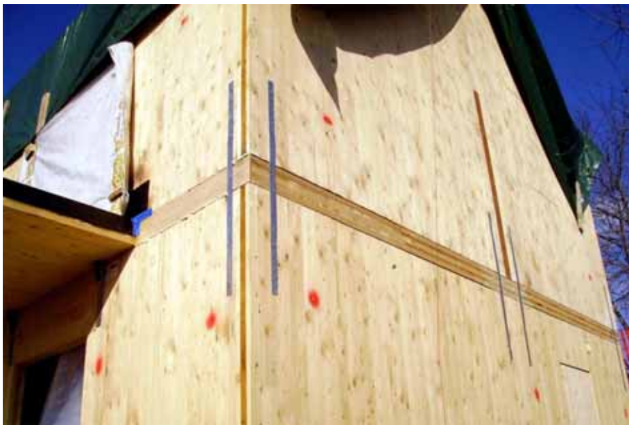
Esempi di ancoraggi tipo per struttura X-lam
