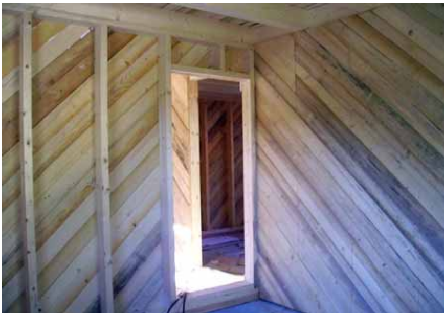
Sistemi intelaiati e controventati con tavole
