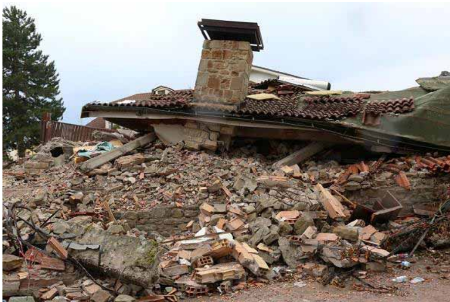
Collassi totale con schiacciamento dall'alto
