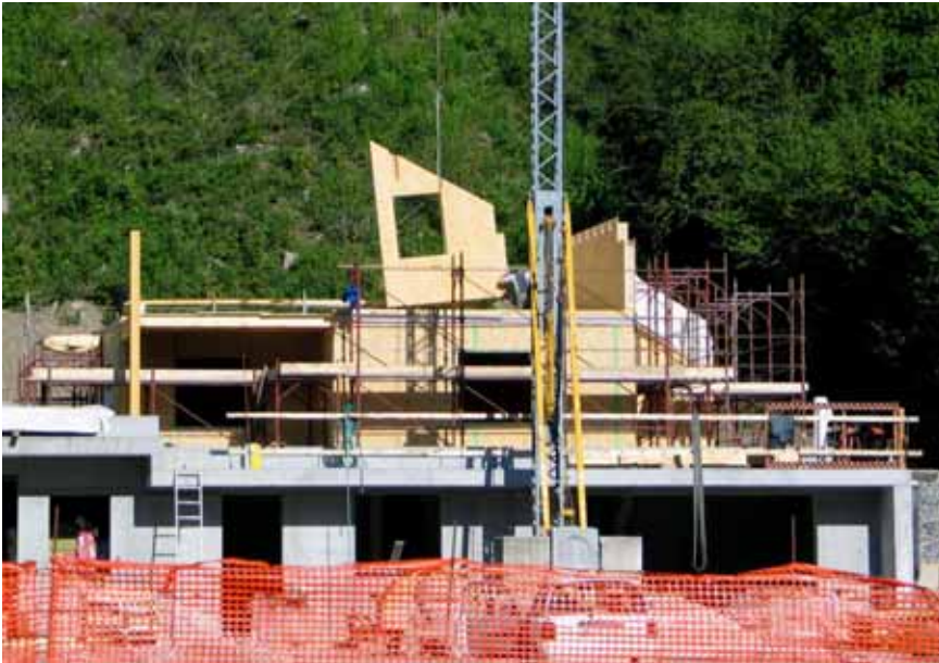
Sistemi intelaiati e controventati con pannelli
